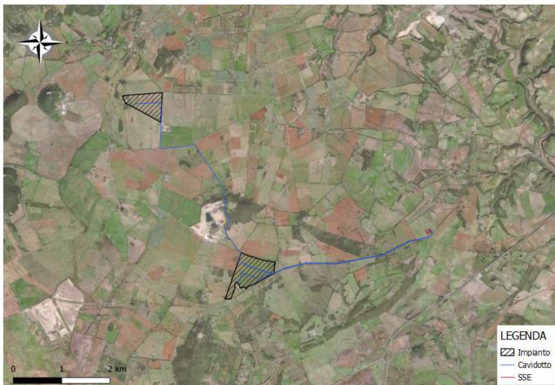
Fig. 1: Immagine aerea dell'area allo studio.
