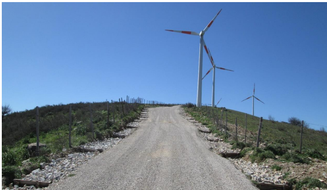
Figura 12: Sistema di fossi di guardia con fondo rivestito in pietrame e briglie.
