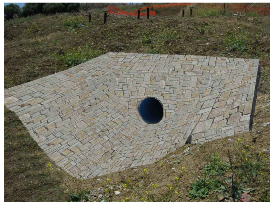
Risultato finale dello zoccolo di protezione
