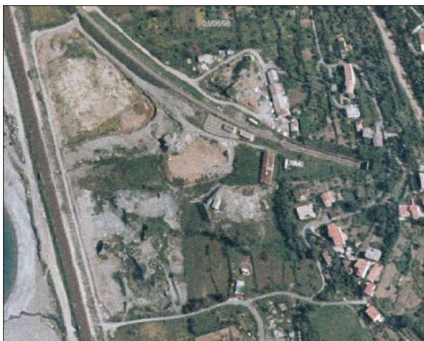
Figura 34: Stato dei luoghi nel 1998, fonte: http://www.pcn.minambiente.it/mattm/servizio-wms/
