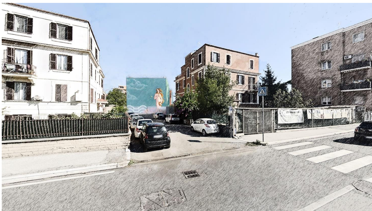
Figura 2-5: Stato Post Operam
