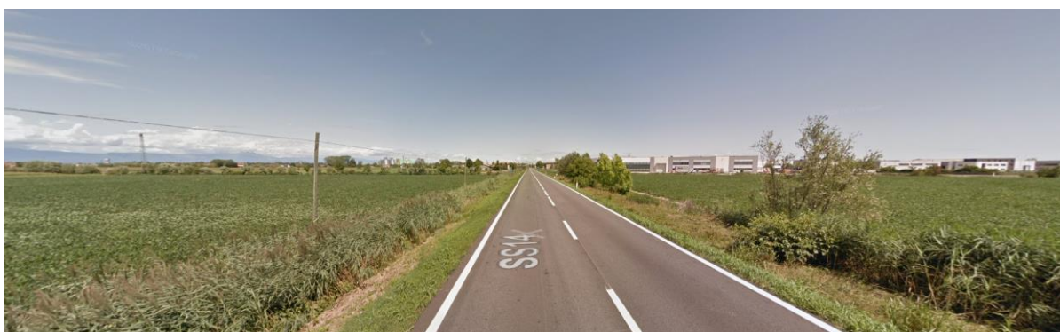
Figura 18 – Zona di intervento in corrispondenza del km 42+070
