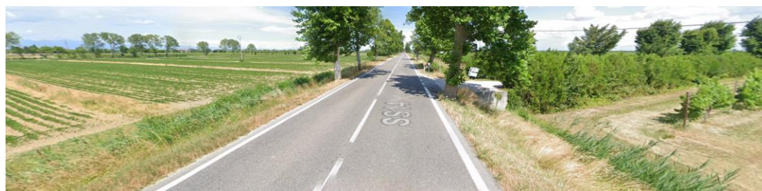
Figura 20 – Zona di intervento in corrispondenza del km 53+500
