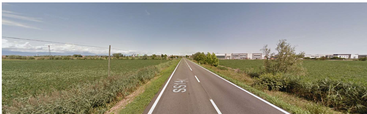
Figura 5 – Zona di intervento in corrispondenza del km 42+070
