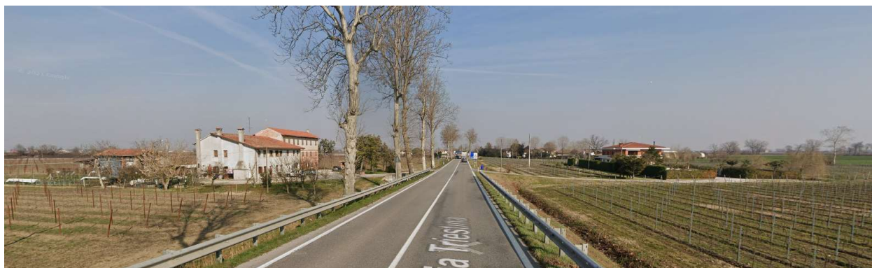
Figura 6 – Zona di intervento in corrispondenza del km 51+700
