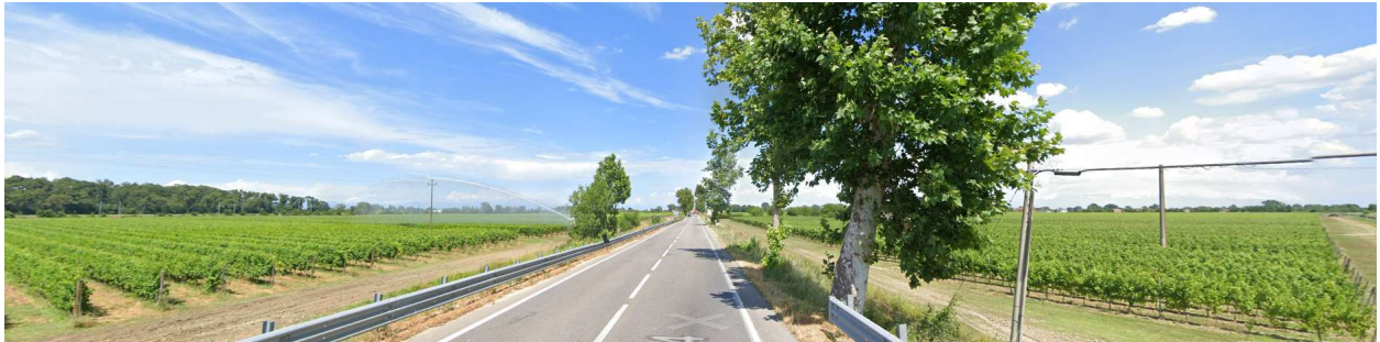
Figura 8 – Zona di intervento in corrispondenza del km 54+550
