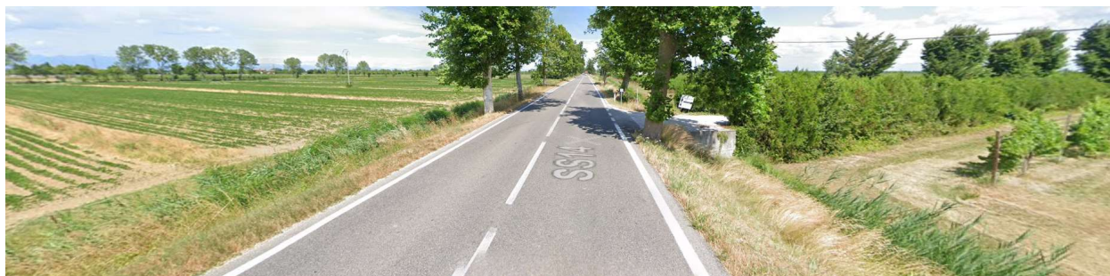
Figura 7 – Zona di intervento in corrispondenza del km 53+500
