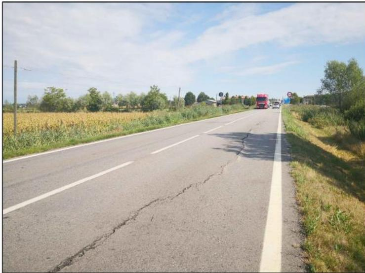
**Figura 3 – Dettaglio dello stato attuale con i cedimenti della sede stradale in lato destro**
