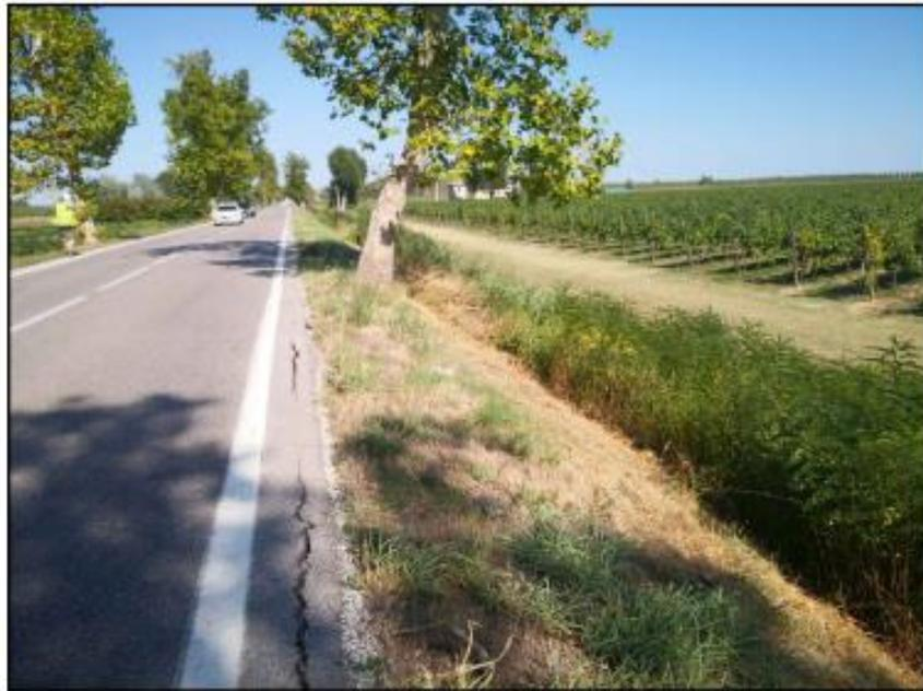
**Figura 7 – Dettaglio dello stato attuale con i cedimenti della sede stradale in lato destro**
