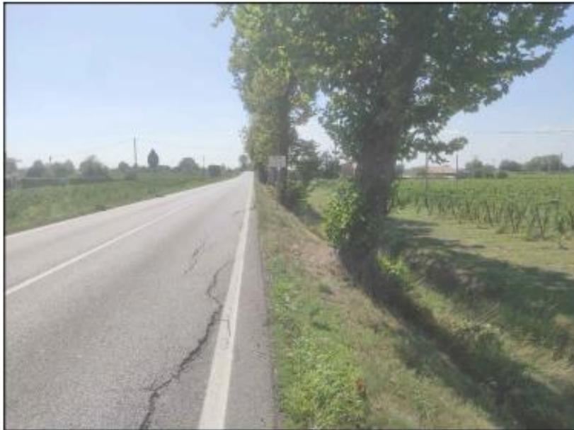
**Figura 5 – Dettaglio dello stato attuale con i cedimenti della sede stradale in lato destro**
