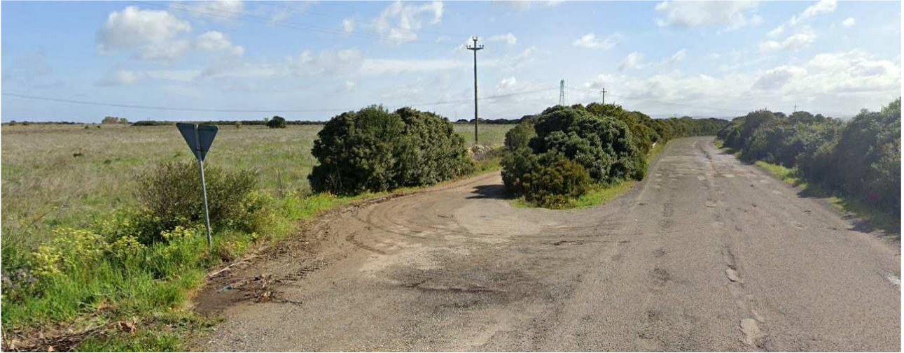
Figura 5.5 – Foto N. 4 – SS N. 65 (sulla destra) e Strada vicinale "Saccheddu" (sulla sinistra)
