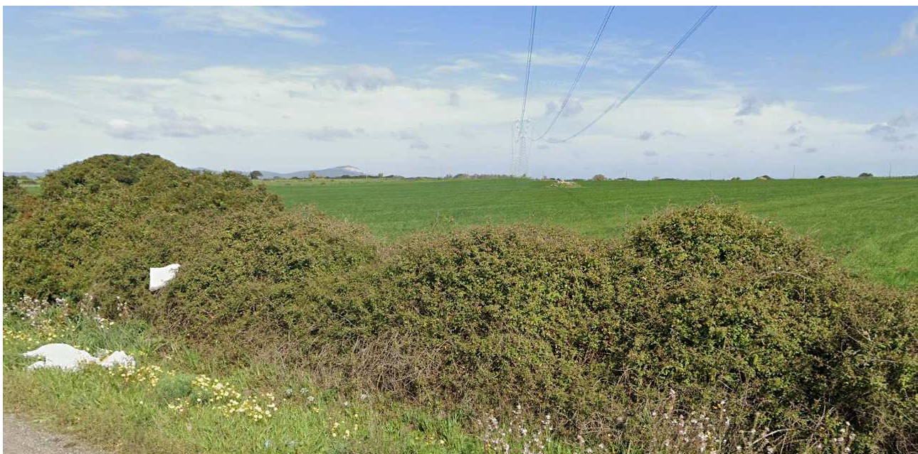
Figura 5.2 – Foto N. 1 – Linea 380 kV “Fiumesanto Carbo – Ittiri” e a sinistra area nuova Stazione RTN “Olmedo”
