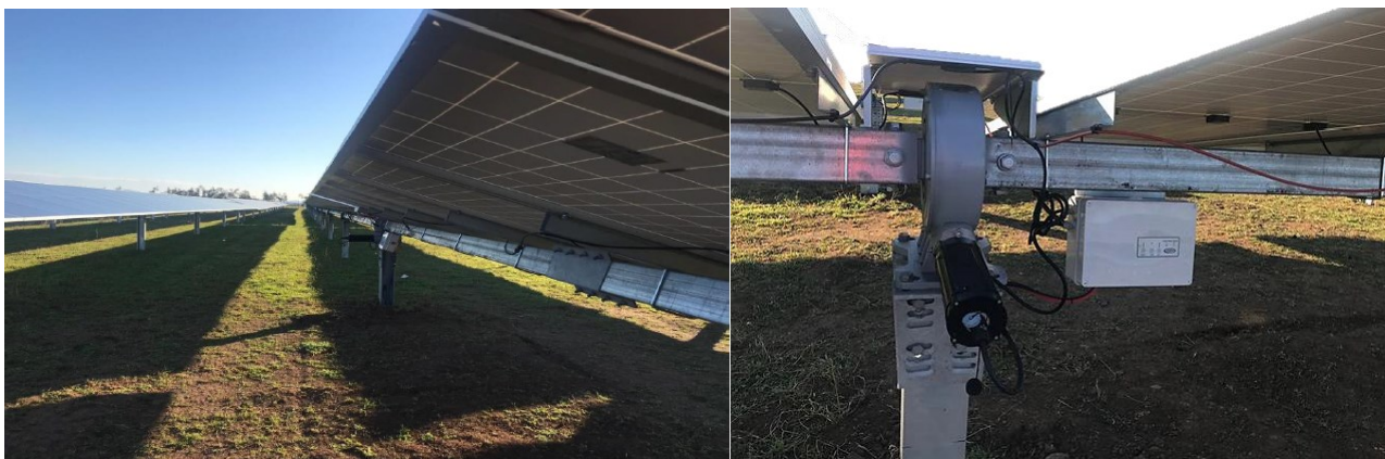
Figura1–Struttura dell’inseguitore monoassiale
