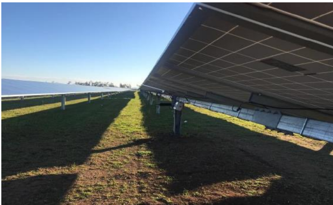
Figura 7 - inseguitore monoassiale SunHunter
