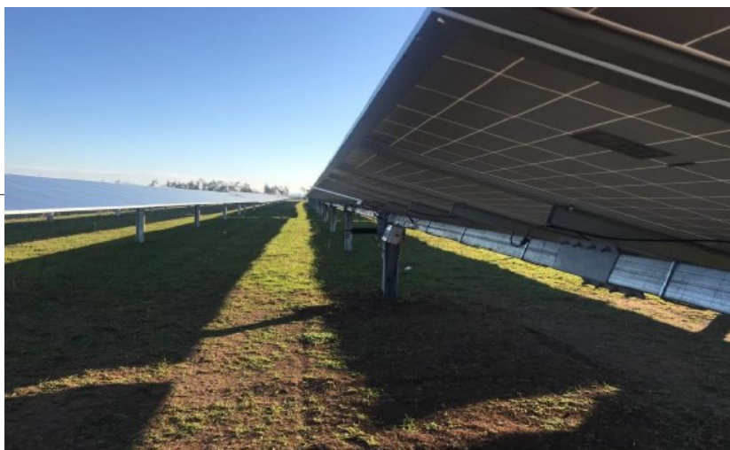
Figura 9: inseguitore monoassiale tipo SunHunter
