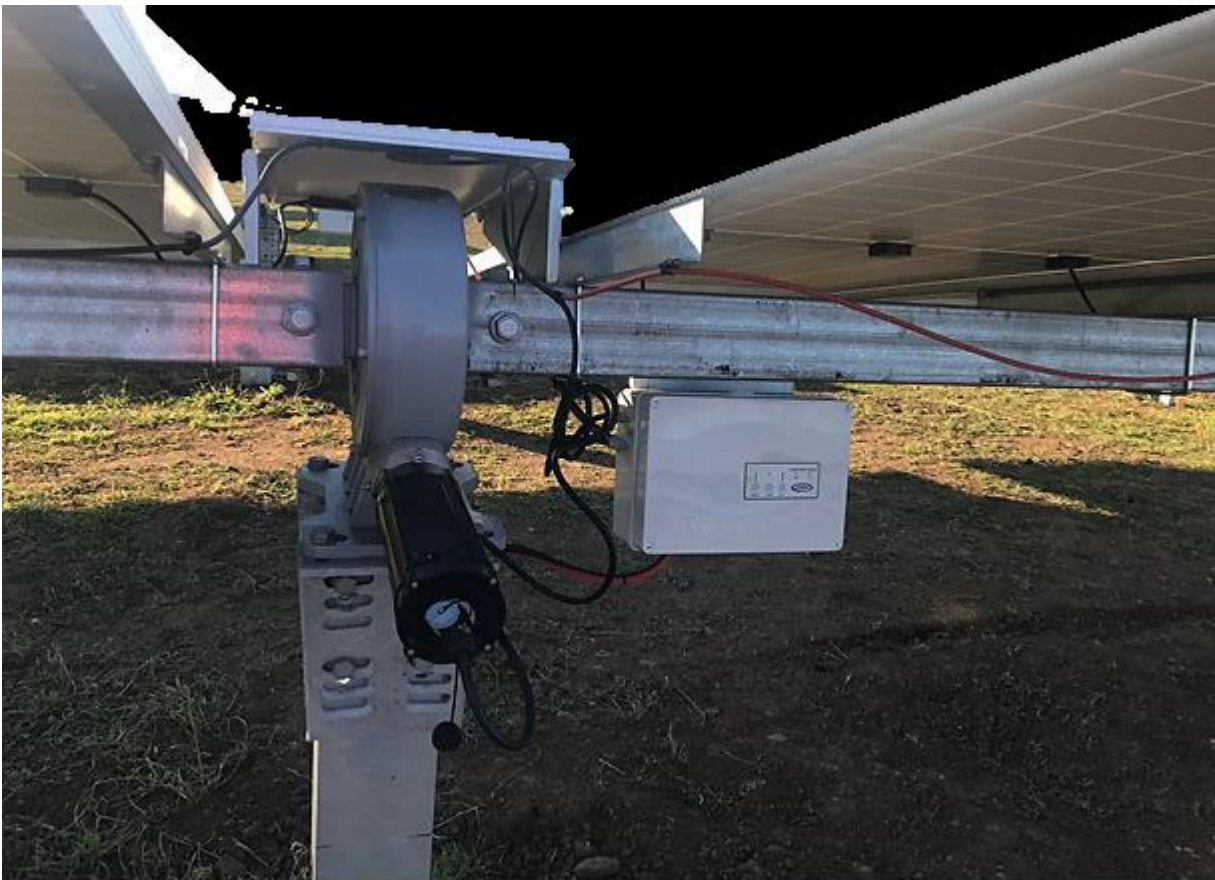
Fig. 15 – Rappresentazione del tracker – vista dell'attuatore elettromeccanico rotativo
