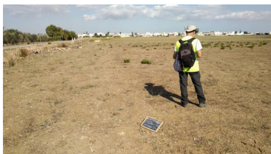
Foto 29 p.Ila 399 posizionamento Cabina di consegna
