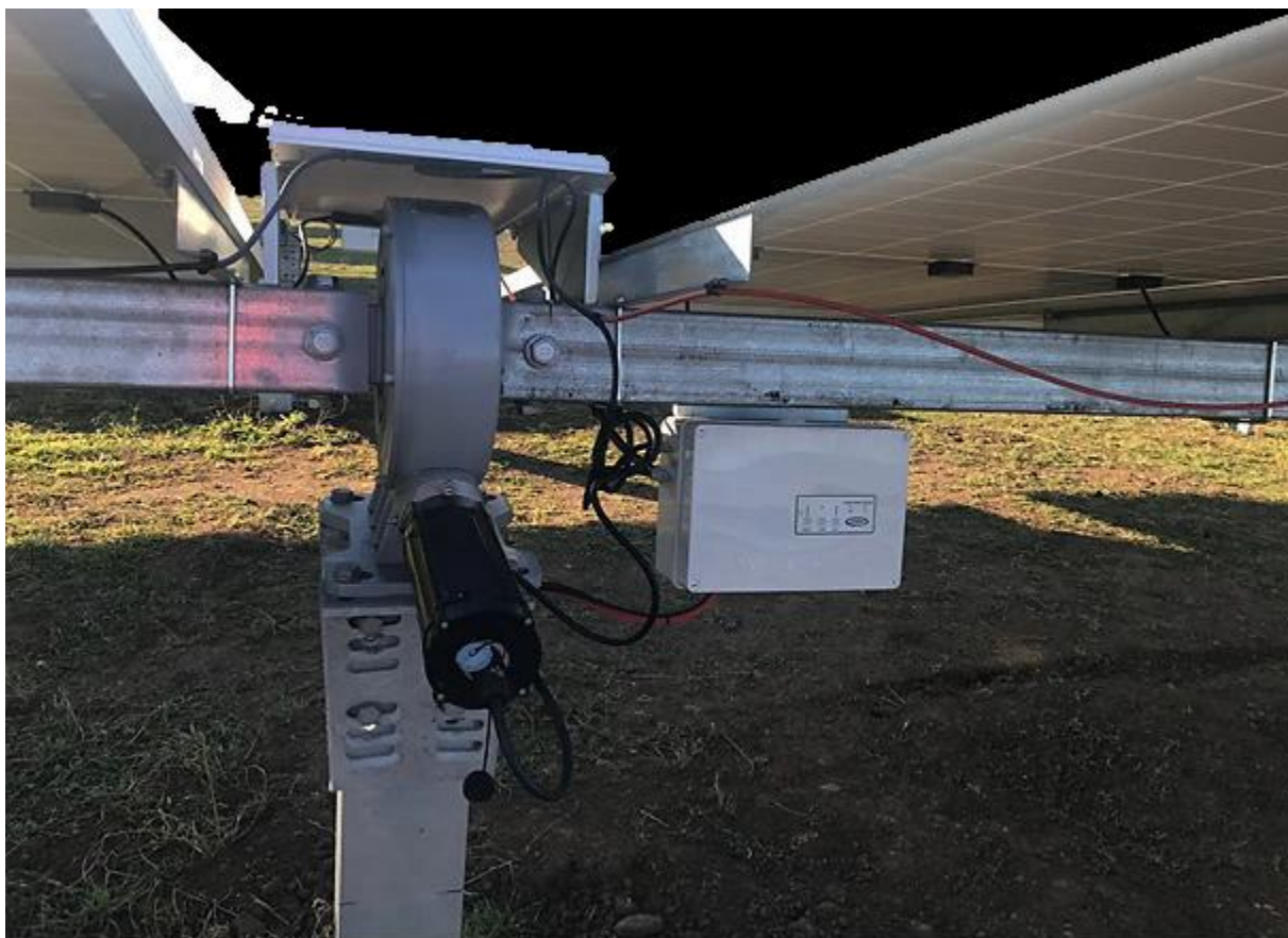
Fig. 15 – Rappresentazione del tracker – vista dell'attuatore elettromeccanico rotativo
