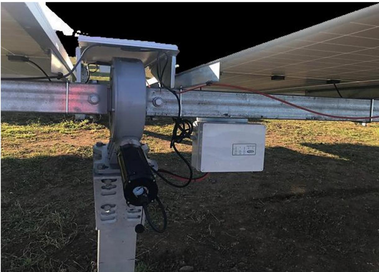
*Fig. 33 – Rappresentazione del tracker – vista dell'attuatore elettromeccanico rotativo*
