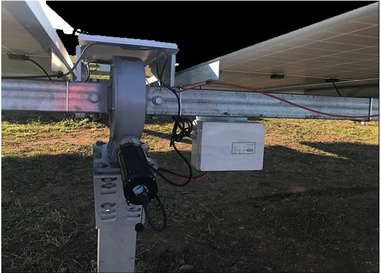
Fig. 4 – Rappresentazione del tracker – vista dell’attuatore elettromeccanico rotativo
