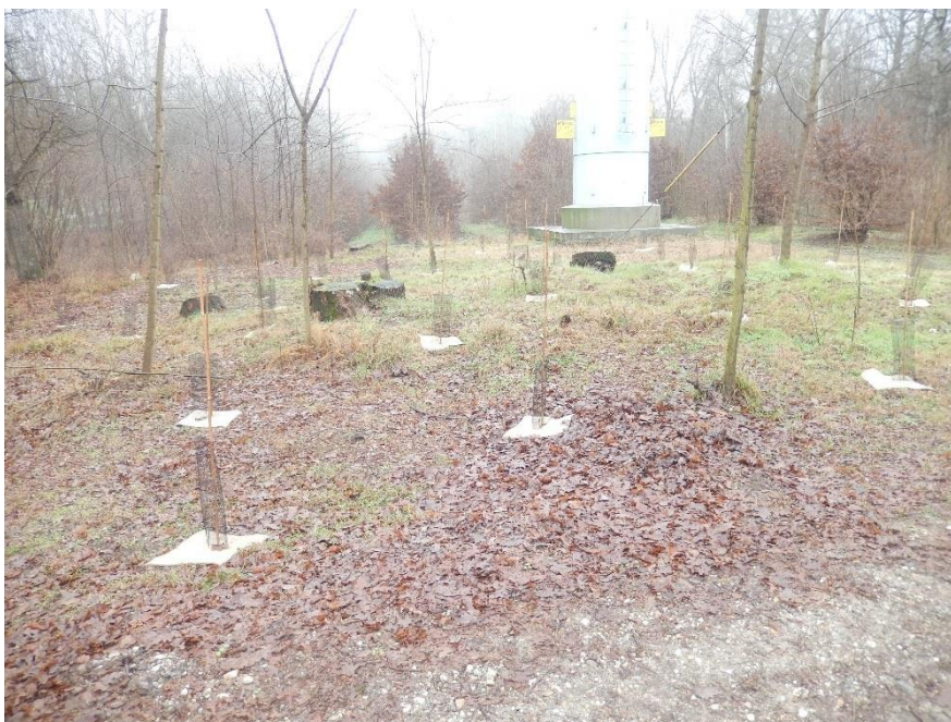
Figura 5 Interventi di ripristino nel Parco naturale della valle del Ticino sulla linea 380 kV Trino-Lacchiarella
