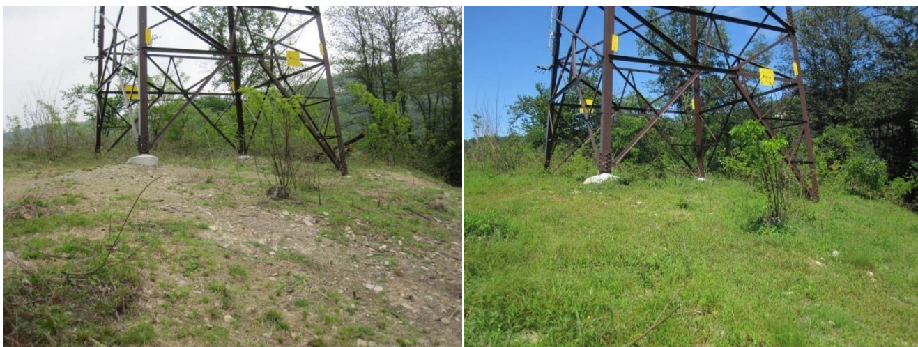
Figura 9 Interventi di rinaturazione ante e post operam sulle linee 132 kV della Val D'Ossola Sud
