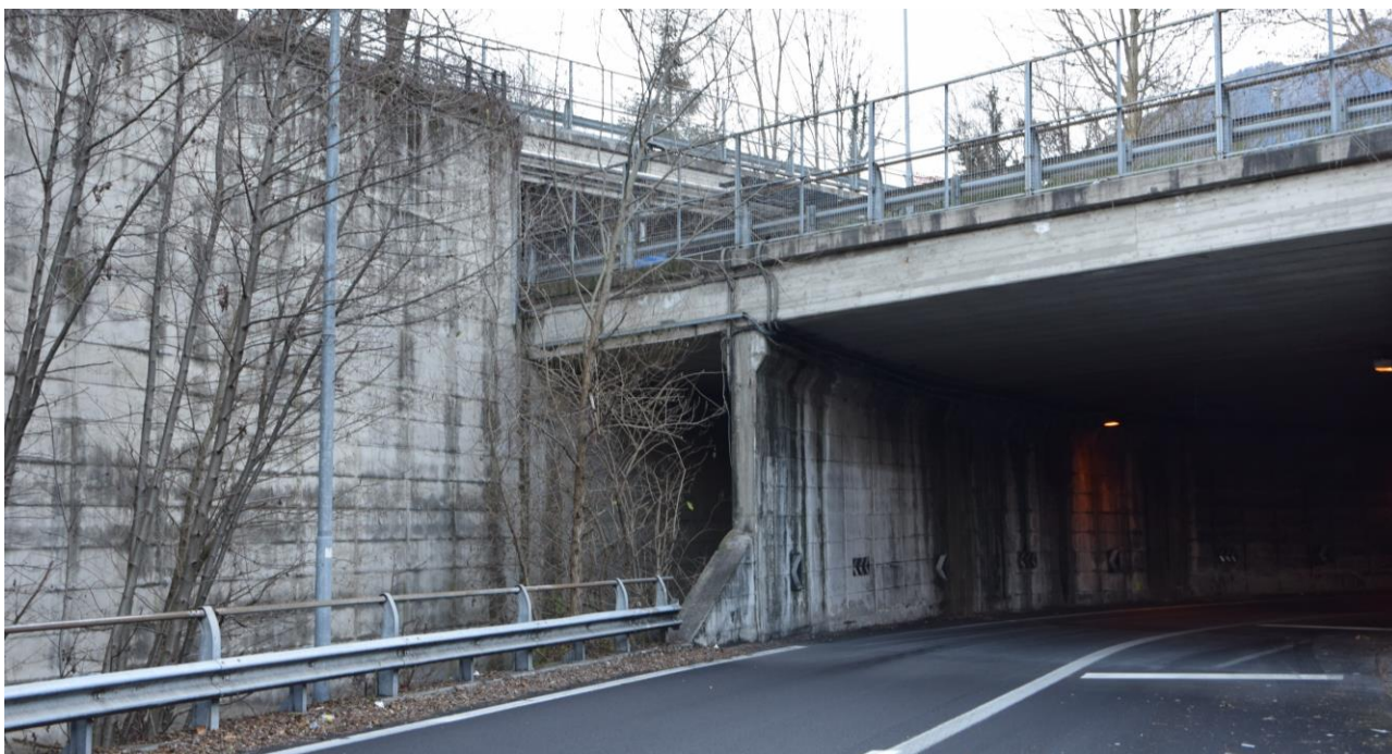
Figura 5 – Sblocco sottoattraversamento torrente Merla
