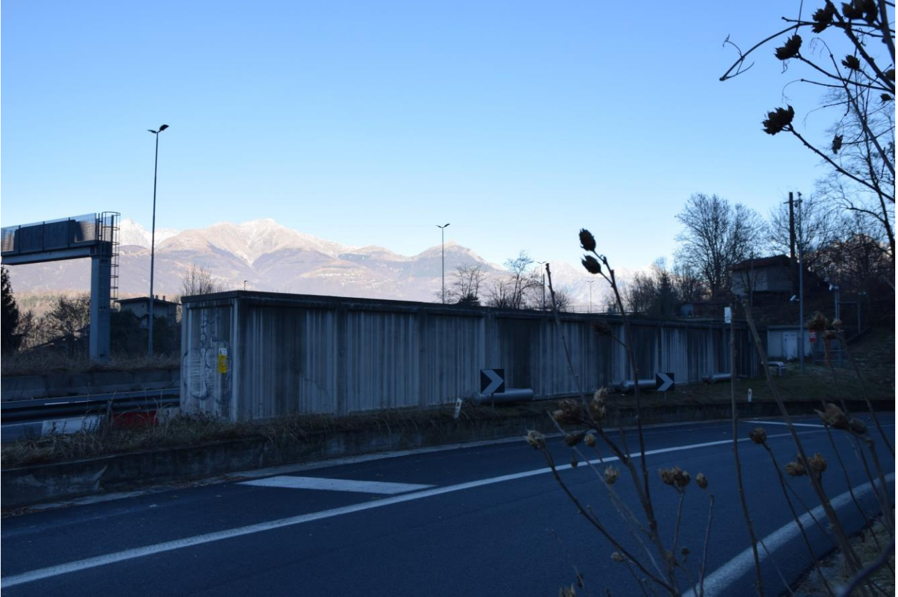
Figura 22 – Impianti antincendio da delocalizzare
