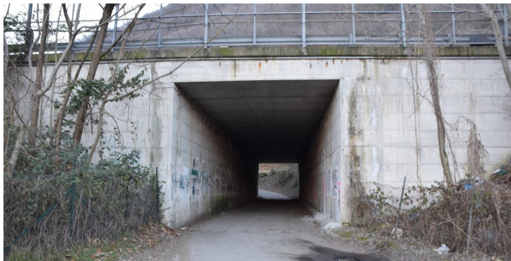
Figura 1-4 Sottopasso carrabile al di sotto della SS36
