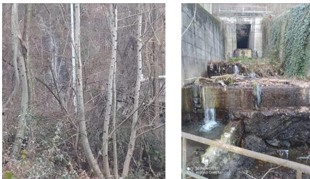
Figura 2-45 Rio che scende da M.te Legnanetto all'altezza della galleria direzione Colico.
