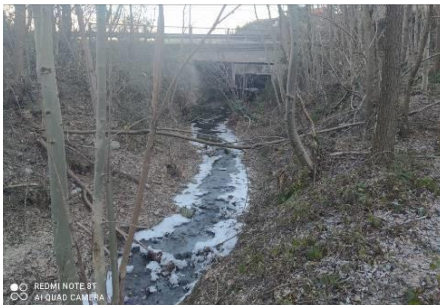
Figura 2-43 T.te Merla, tratto prima di attraversamento strada provinciale.
