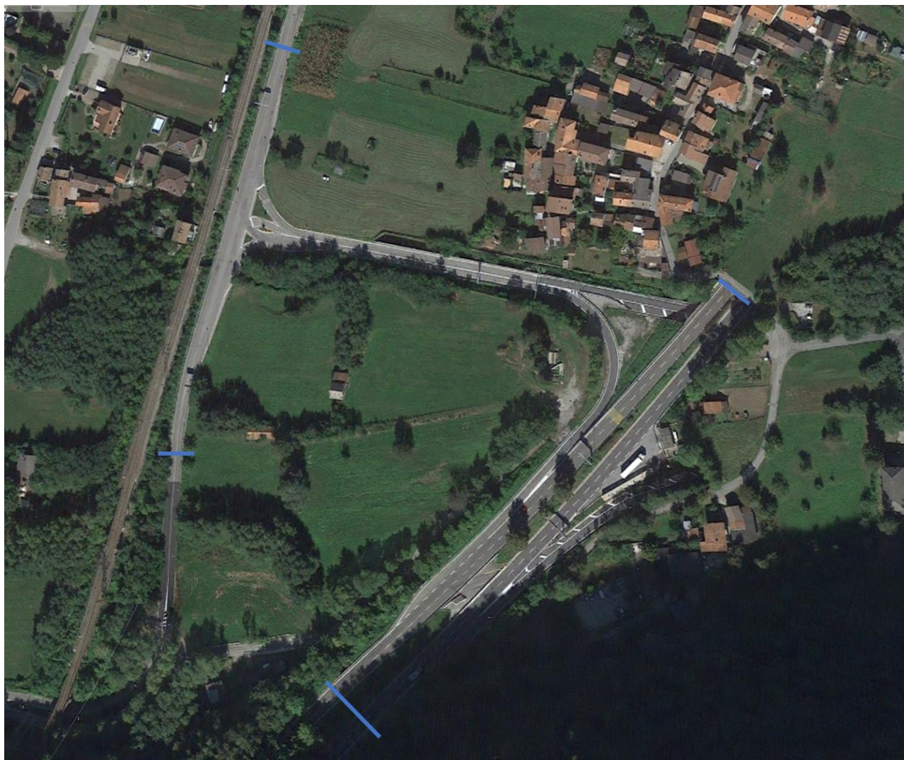
Figura 2-112 Rappresentazione tratto stradale di riferimento (in blu vengono definiti i confini della rete stradale presa in considerazione per le simulazioni)
