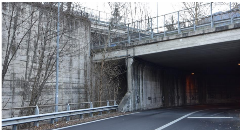
Figura 1-3 – Sbocco sottoattraversamento torrente Merla
