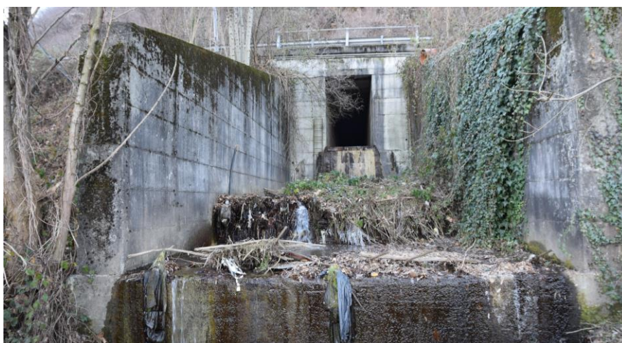
Figura 1-2 – Sbocco del tombino idraulico al di sotto della SS36
