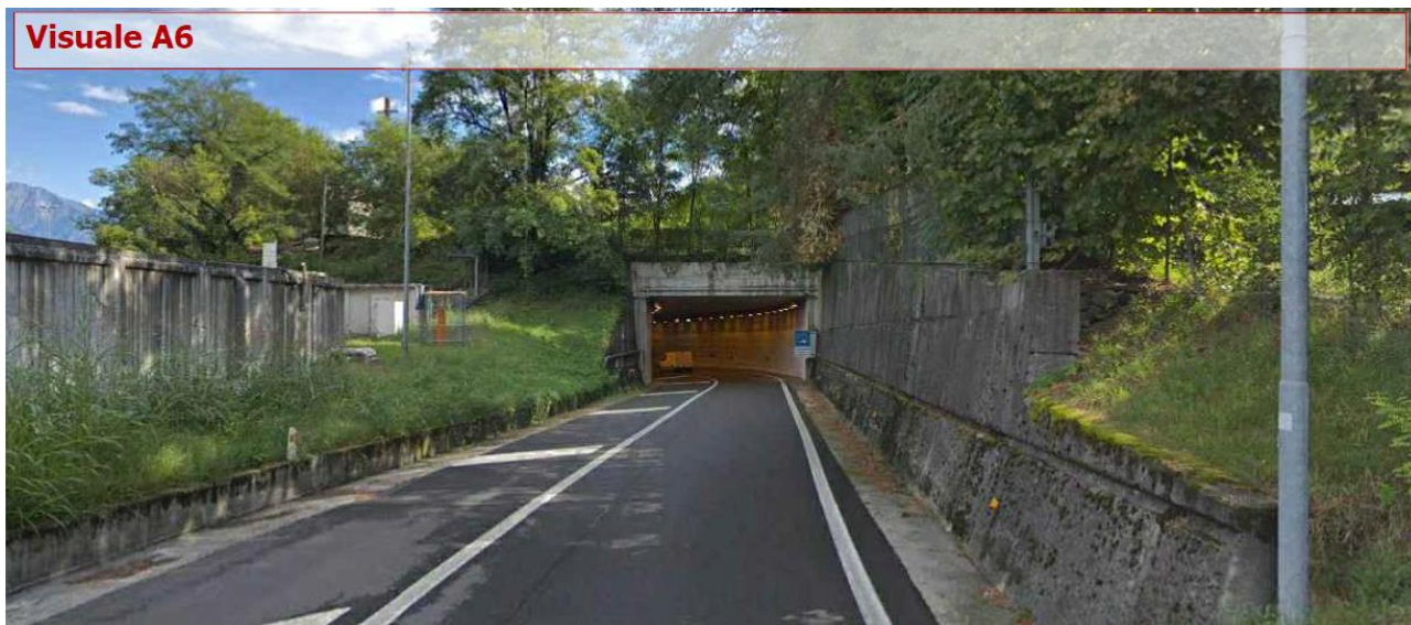
Figura 2-136 - Visuale occlusa – Zona di intervento schermata da barriere artificiali e vegetazionali all'uscita dalla SS36 in direzione nord lungo lo svincolo Piona
