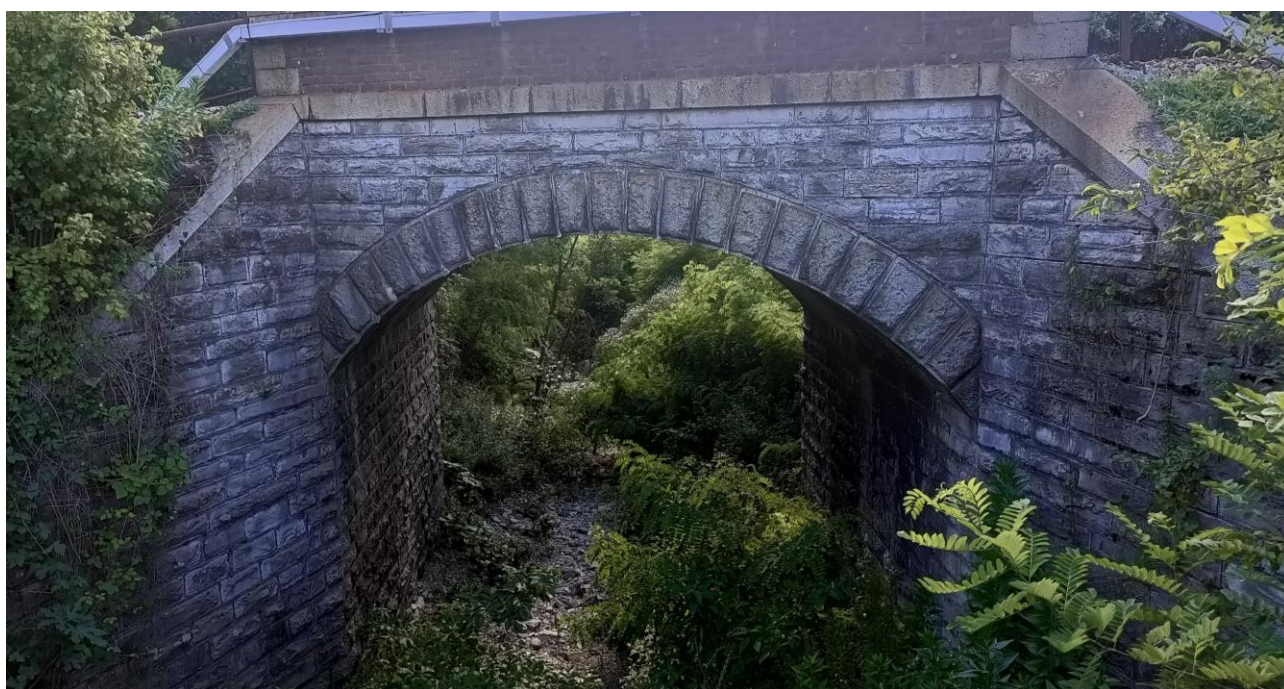
Figura 3-23 – Sopra fascia arborea arbustiva lungo il corso del Valle Marta, sotto, ponte ferroviario di attraversamento sul corso d'acqua oltre il margine ovest della SP72/Via Nazionale Sud
