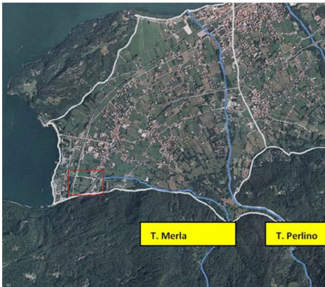
Figura 2: conoide alluvionale dei torrenti Merla e Perlino e le propaggini nord del Monte Legnoncino
