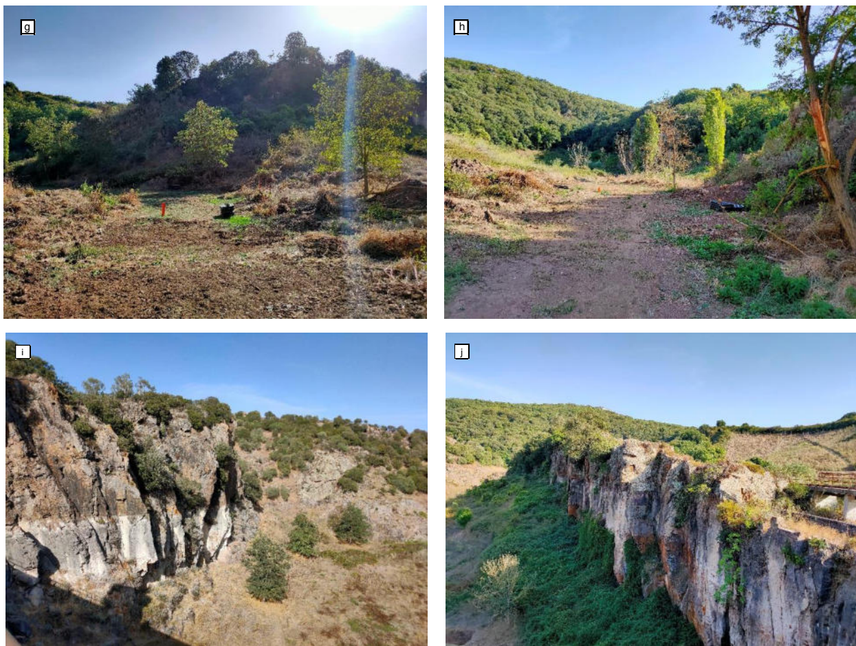
Figura 7 Foto del sopralluogo del 13/09/2022: aree vasca e savanella (a, b, c, d), aree opera di presa e argine (e, f, g, h), parete a sinistra e destra della diga (i,j) interessate dalla messa in sicurezza.
