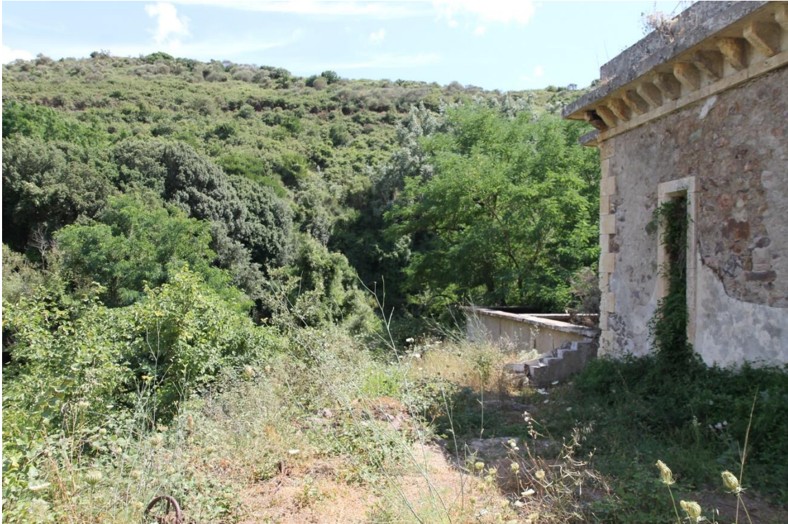
Veduta Est dell'area dell'Edificio Filtri
