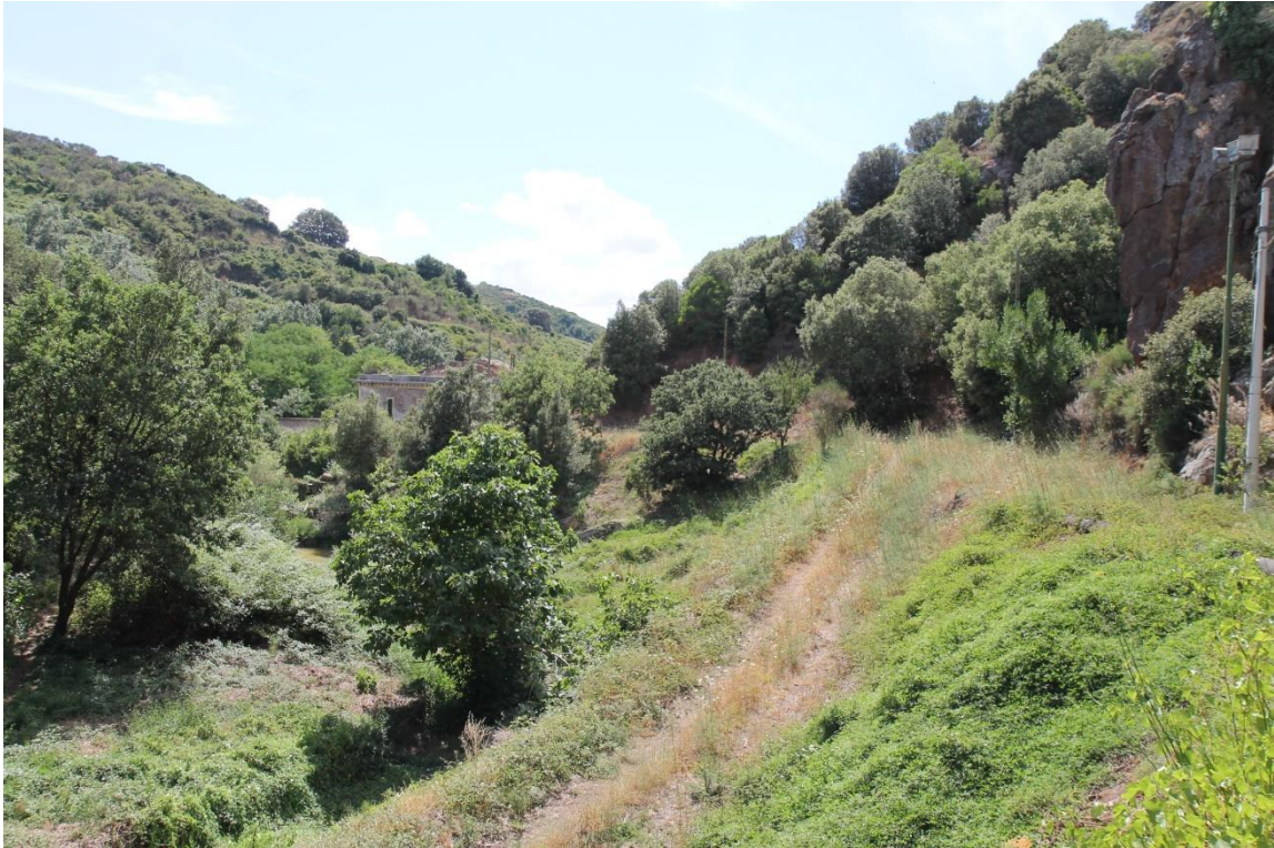
Veduta a sud della diga di Bunnari Basso
