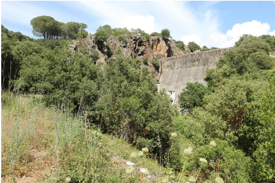
La diga di Bunnari Basso vista dall'Edificio Filtri
