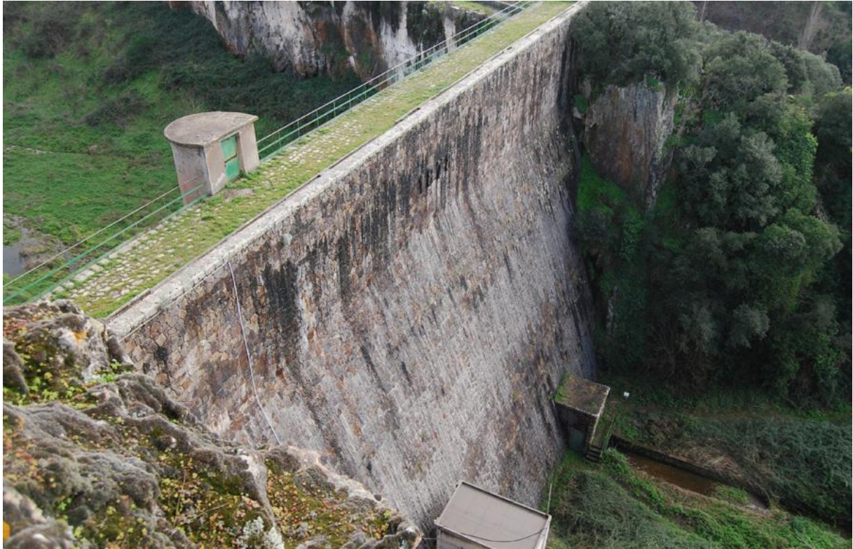
La diga di Bunnari Basso vista da sud est
