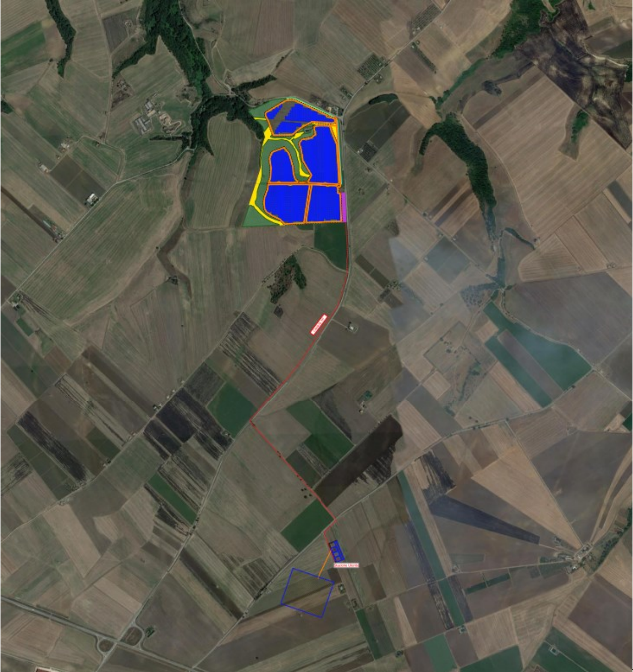
Ortofoto con l'individuazione dell'impianto in progetto, del cavidotto esterno MT e della stazione Terna S.p.A. a realizzarsi.
