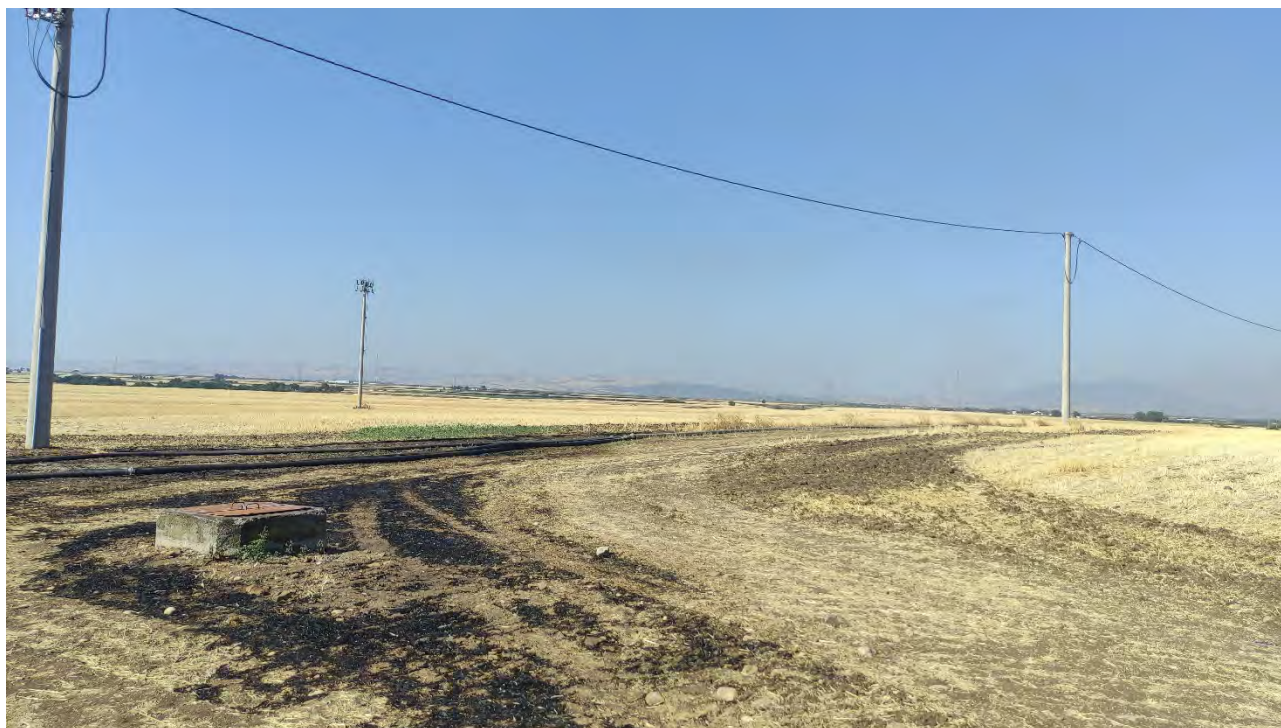
Foto 3 – Dettaglio 3 dell'area interessata dall'impianto.
