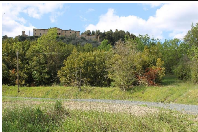
□ Vista in direzione nord-ovest verso Casagia foto Ambiente Italia
