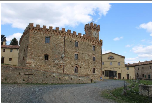
□ Vista del castello e dei fabbricati sul lato sud ed esterno del borgo che chiudono il campo visivo verso nord
