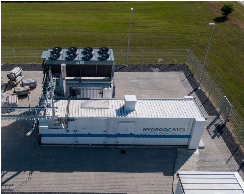
Elettrolizzatore e suoi ausiliari
