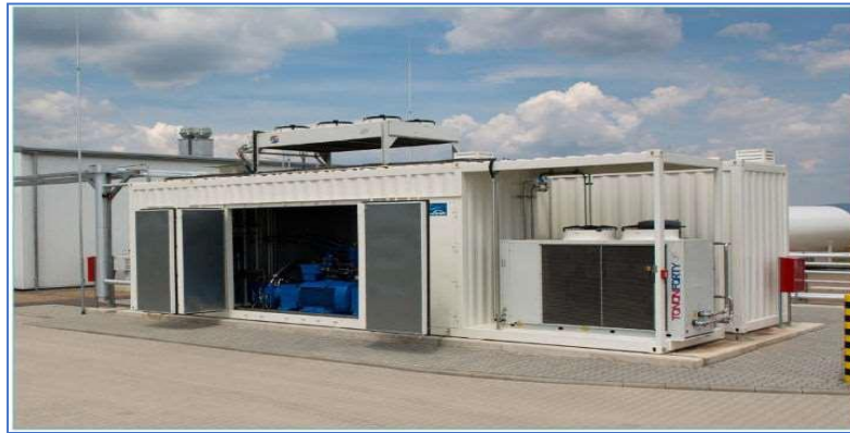
Compressore a idrogeno ad alta pressione
