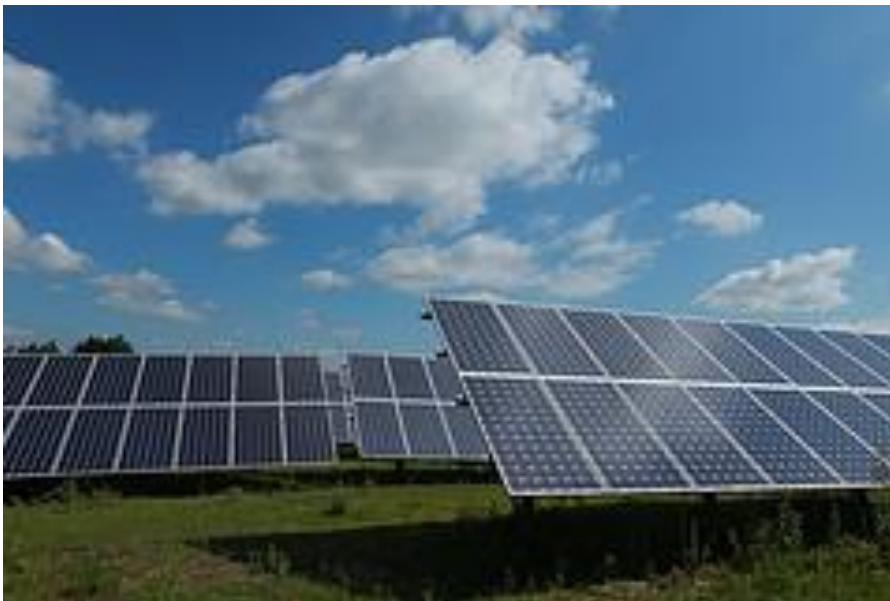
Figura 1 – esempio pannello monoassiale installato
