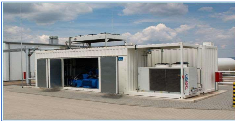
Compressore a idrogeno ad alta pressione
