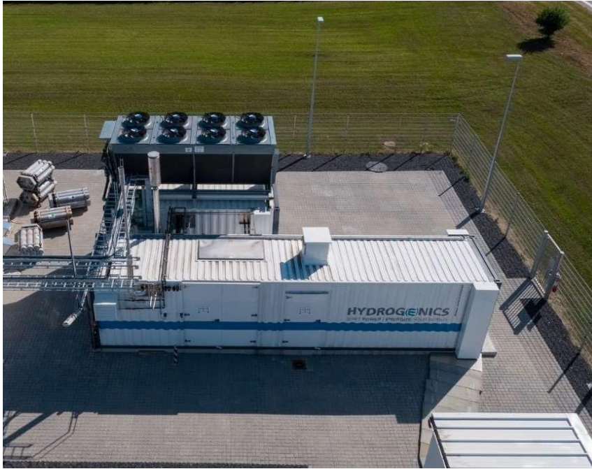
Elettrolizzatore e suoi ausiliari
