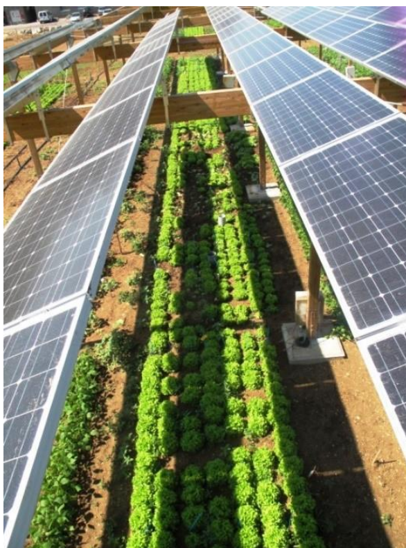
Fig. 9: Immagine di un impianto sperimentale Agro-Fotovoltaico
