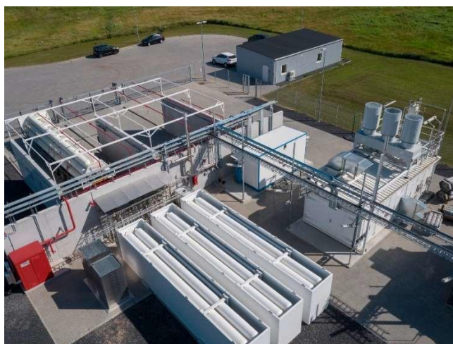
Serbatoi a forma di tubo per stoccaggio ad alta pressione
