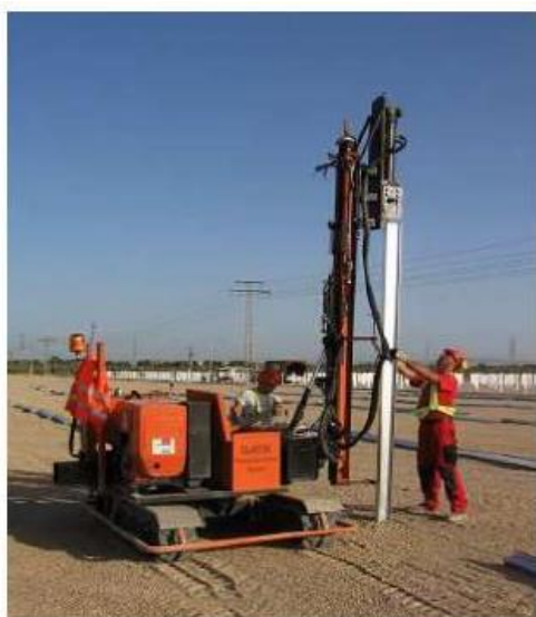
Figura 3 - Esempio pali di fondazione infissi nel terreno
