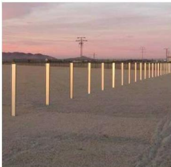
Figura 3 - Esempio pali di fondazione infissi nel terreno
