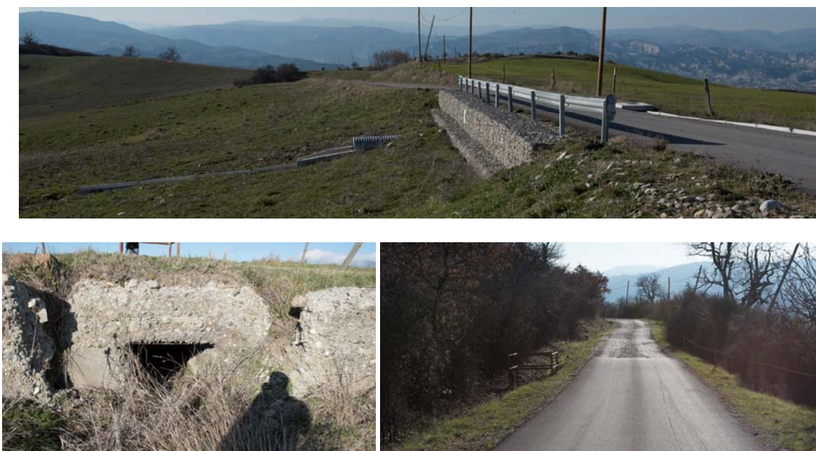
Figura 31: Interferenze con opere idrauliche esistenti di varia tipologia
