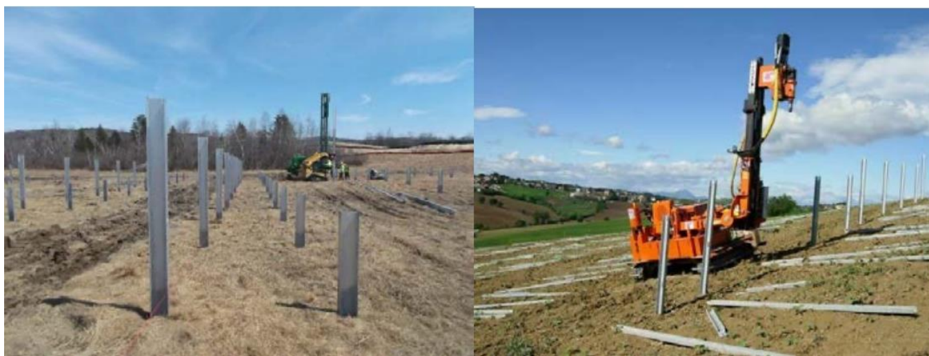
Figura 7: Infissione profili di palificazione
