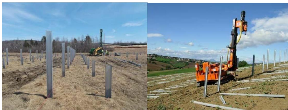
Figura 10: Infissione profili di palificazione
