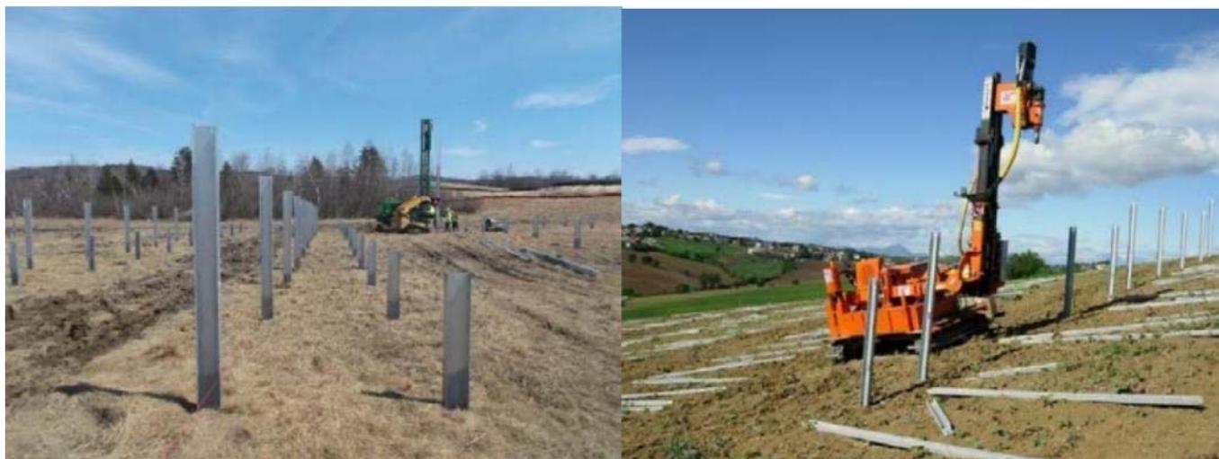
**Figura 19: Infissione profili di palificazione**
