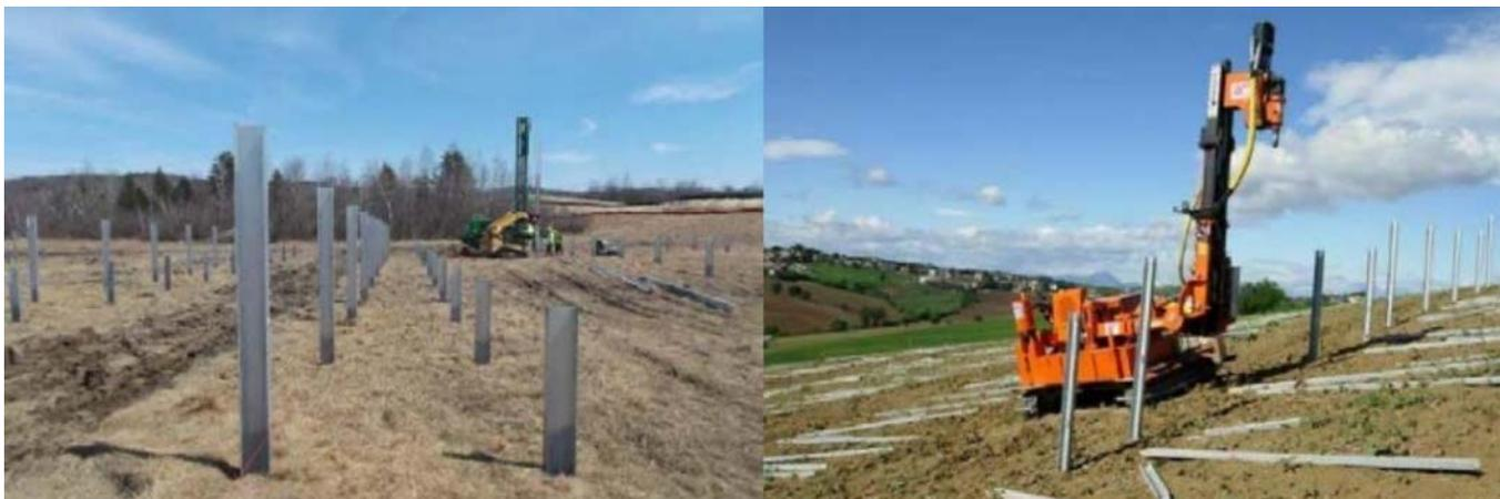
**Figura 7: Infissione profili di palificazione**
