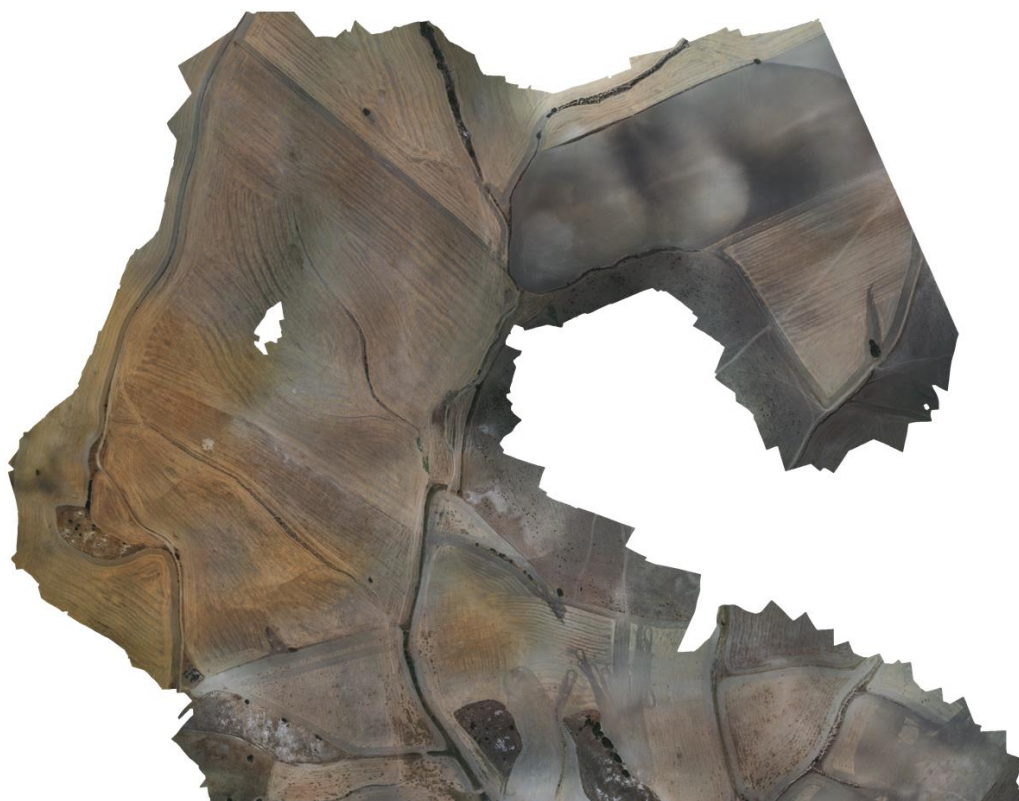
Figura 103 - Vista dall'alto delle aree di intervento (Fonte: nostra riproduzione con utilizzo di drone)
