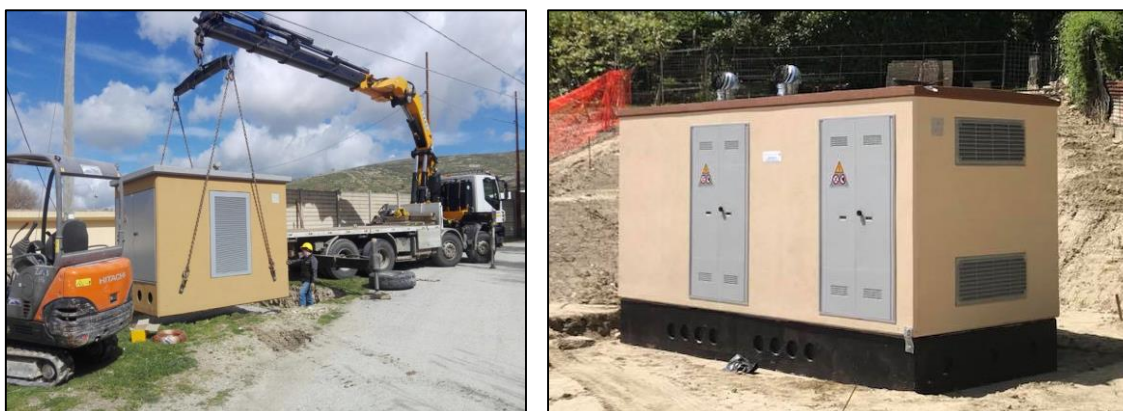
Figura 8 - Fasi di scarico cabine prefabbricate in cav
