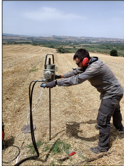
Fig. 1.5.9 – Esecuzione indagine penetrometrica dinamica media - D.P.M. 5
