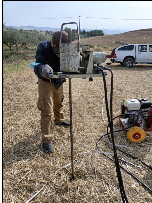
Fig. 1.5.13 – Esecuzione indagine penetrometrica dinamica media - D.P.M. 7
