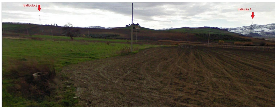
Figura 4.26: Tralicci in Alta Tensione preesistenti (visuale da strada adiacente il Nuovo Satellite 36/150 kV)
