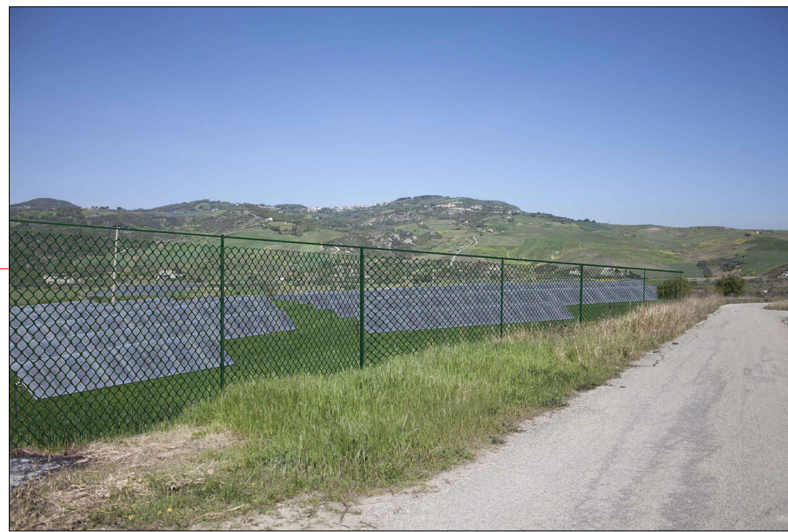
④ (41°58'29.61"N - 14°42'41.74"E) VISTA DELL'IMPIANTO SENZA MITIGAZIONE
