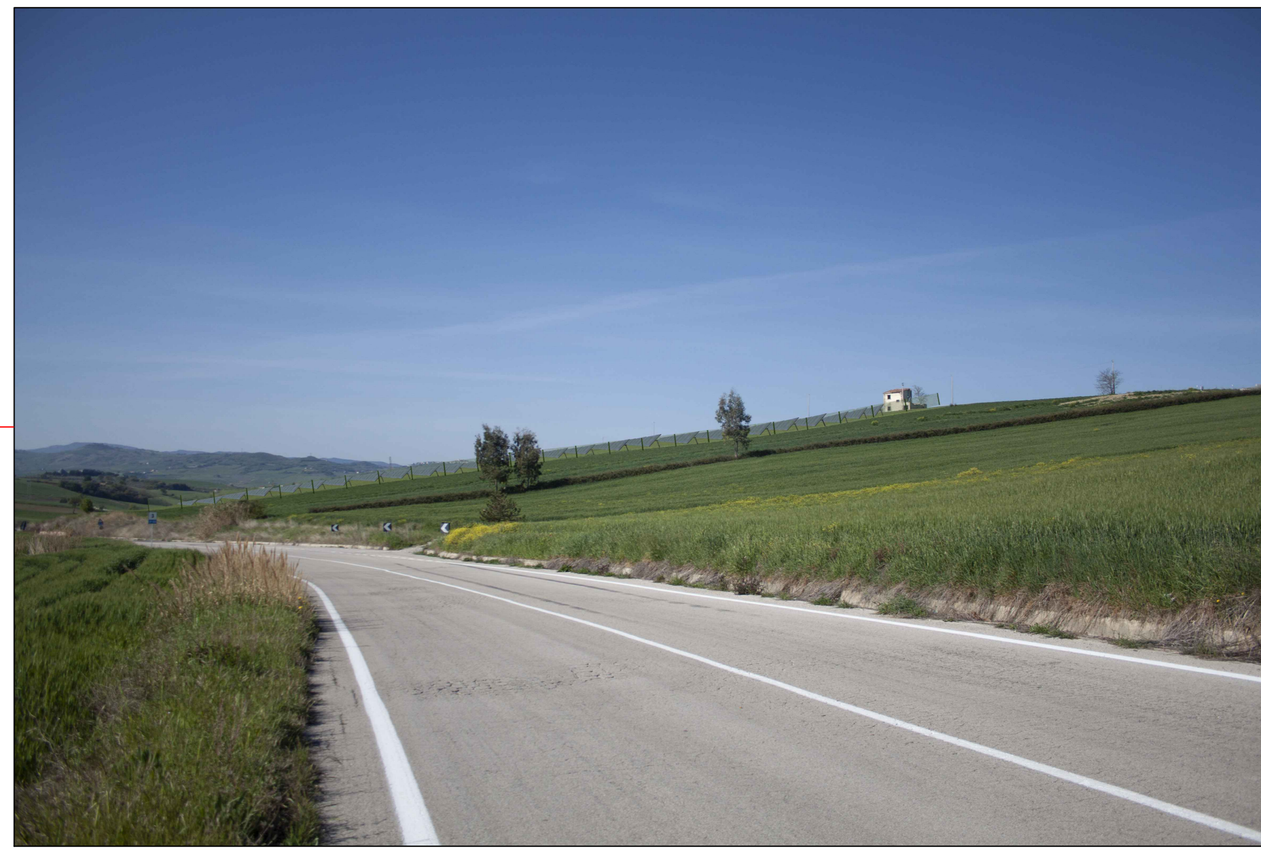
⑤ (Strada Comunale Chiatalonga) VISTA DELL'IMPIANTO SENZA MITIGAZIONE
