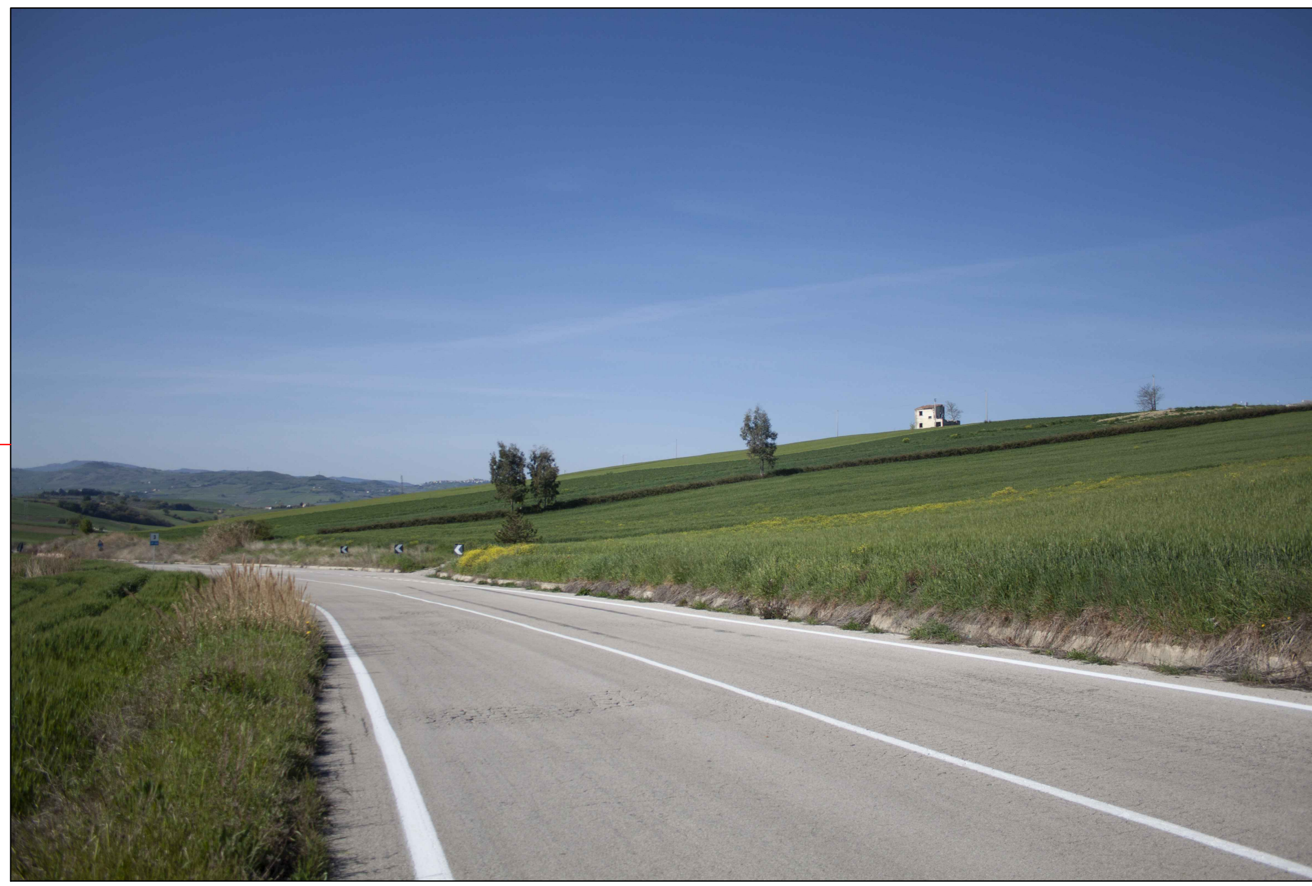
⑤ (Strada Comunale Chiatalonga) VISTA DELL'IMPIANTO ANTE-OPERAM
