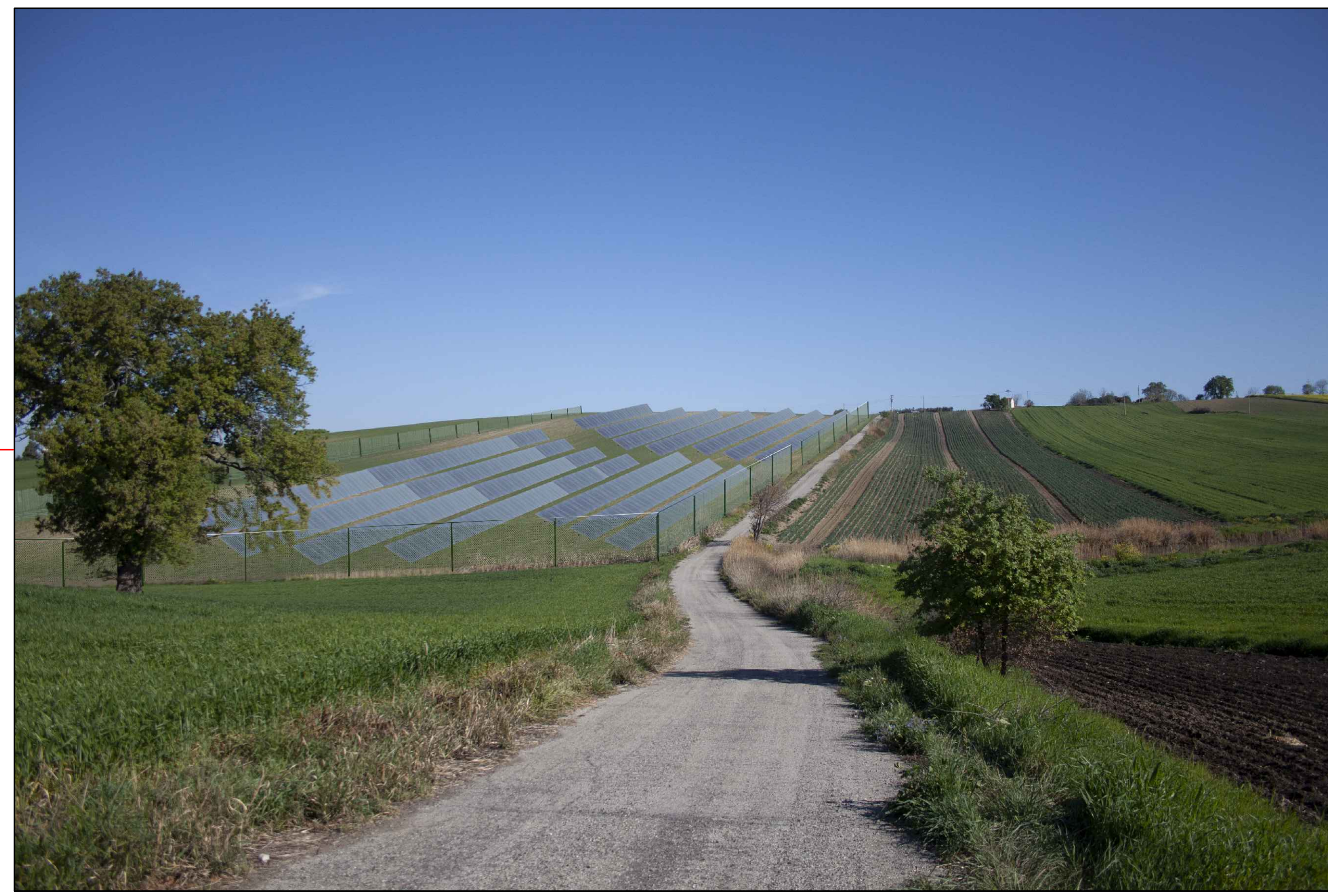
8 (S.da Statale n.157) VISTA DELL'IMPIANTO SENZA MITIGAZIONE
