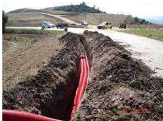
*Figura 160 - Posa cavidotto MT tipo*
