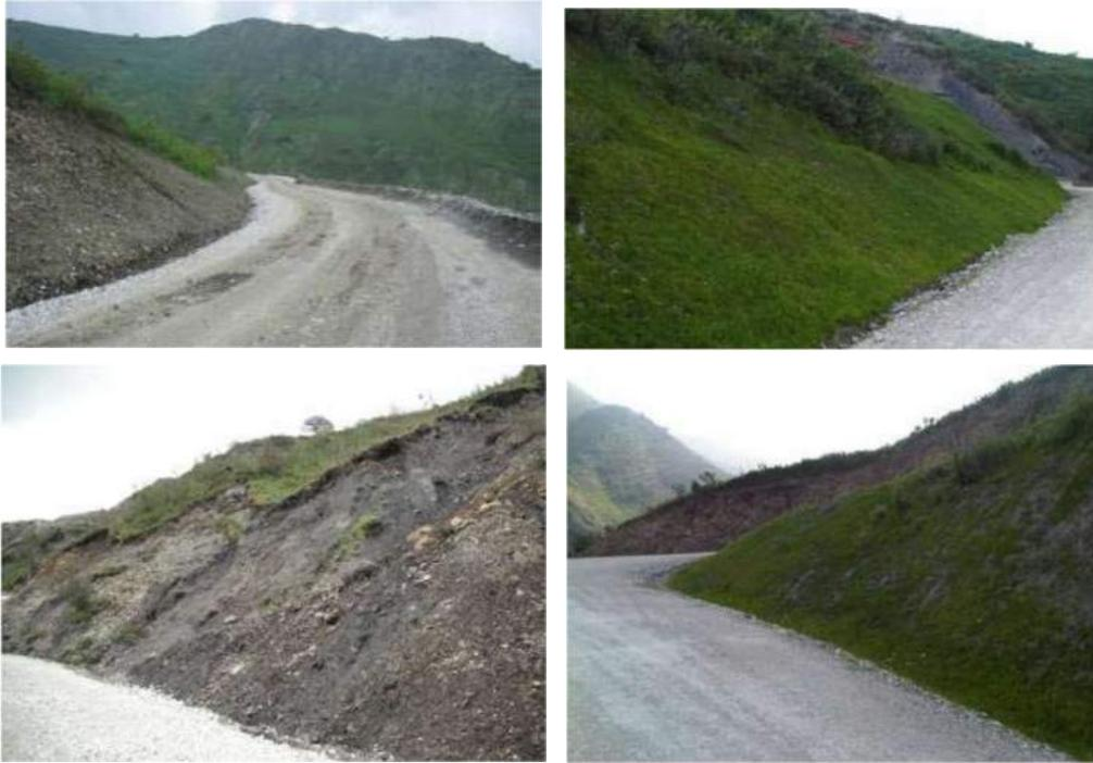
*Figura 79 - Esempi di inerbimento post-operam delle scarpate oggetto di intervento, ove e se necessari*
