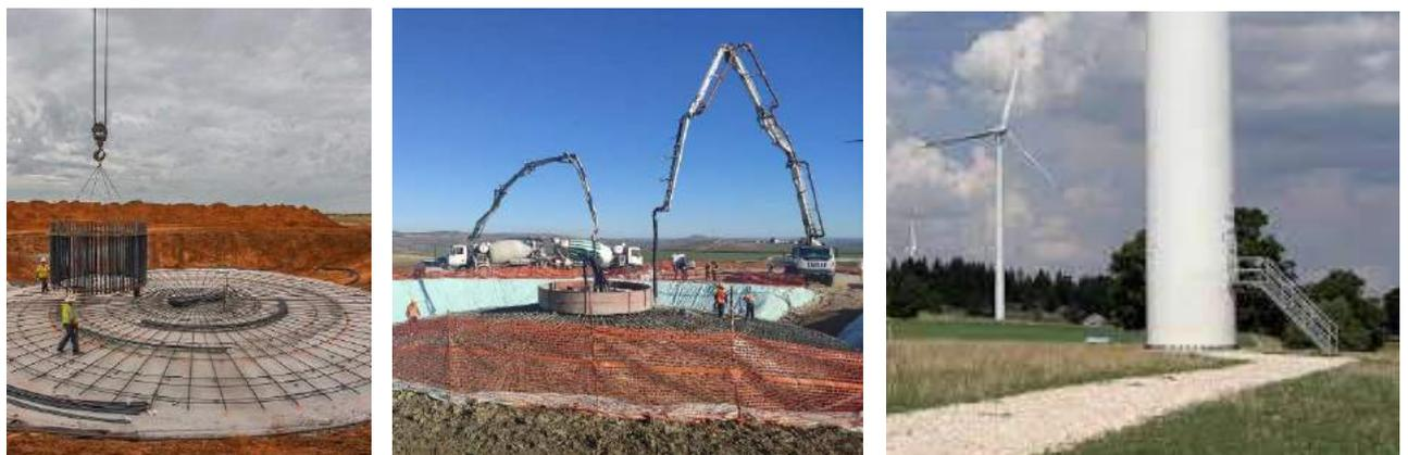
Figure 70 - Immagini tipo di alcune fasi di lavorazione della Fondazione degli aerogeneratori
