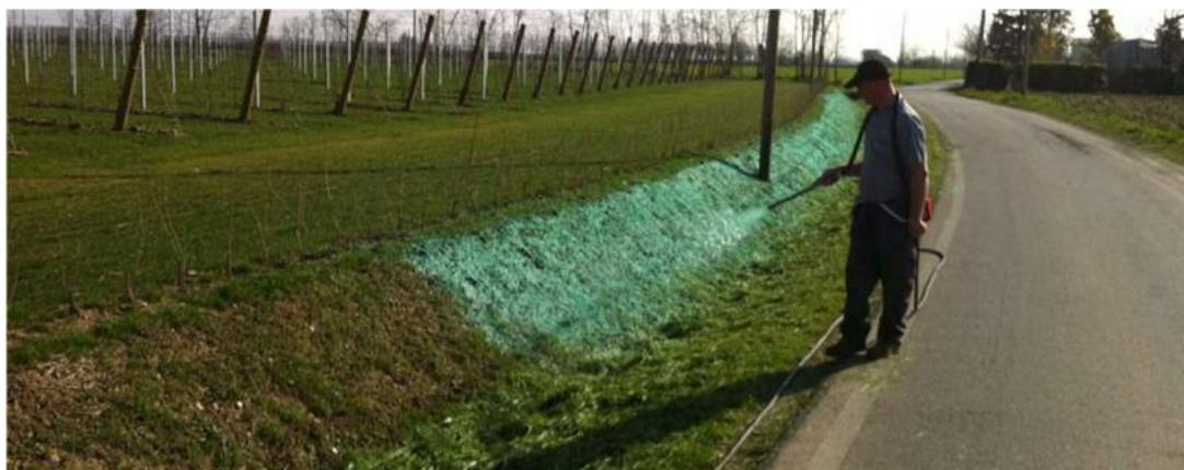
Figura 92 - Sistema di idrosemina
