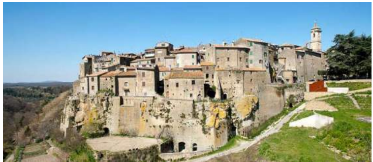
Figure 45 - Immagini del centro abitato di Valentano
