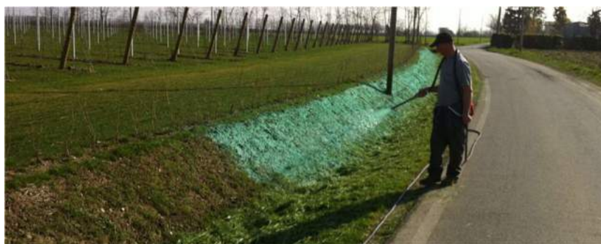
Figura 33 - Sistema di idrosemina
