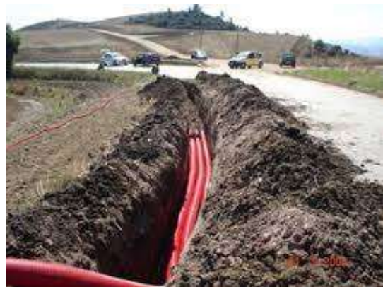
Figura 66 - Posa cavidotto MT tipo
