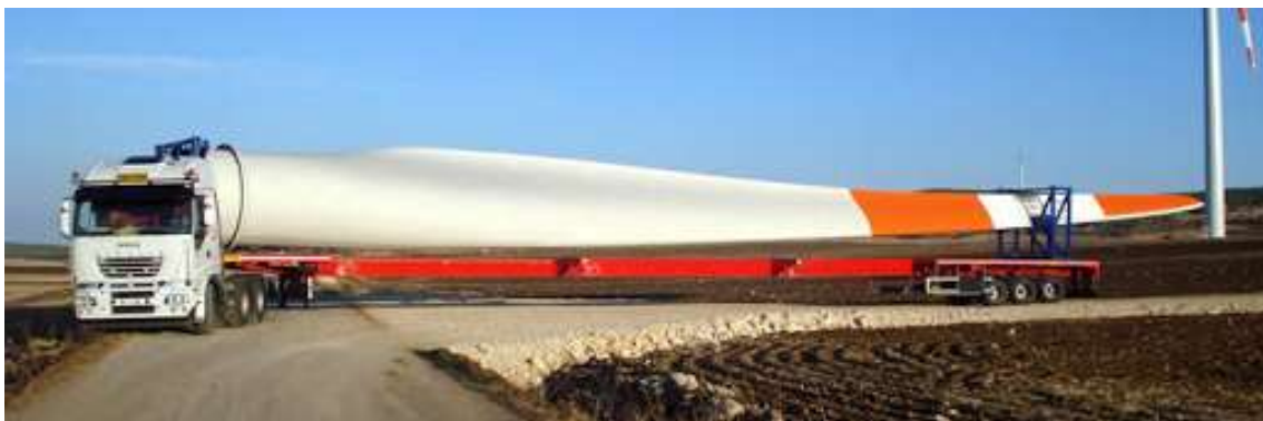
Figura 30 - Soluzione tipo del trasporto delle pale e pista di nuova realizzazione tipo per l'accesso alla turbina
