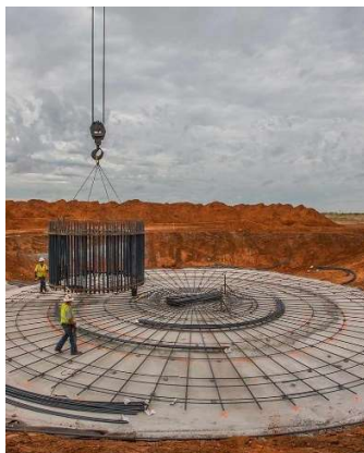
Figure 17 - Immagini tipo di alcune fasi di lavorazione della Fondazione degli aerogeneratori
