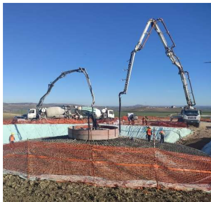
Figure 17 - Immagini tipo di alcune fasi di lavorazione della Fondazione degli aerogeneratori
