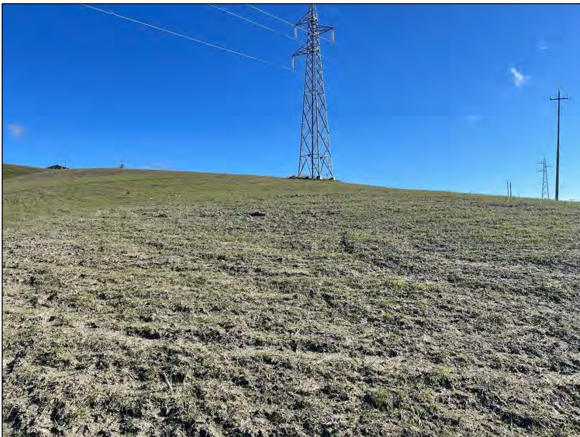
Foto 32 - Panoramica UR 17 (sostegno 063 N linea 135)
