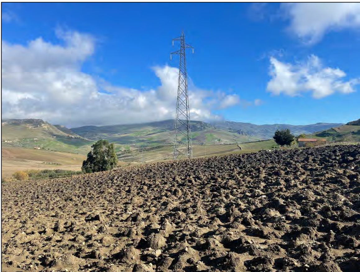
Foto 39 - Panoramica UR 21 (sostegno 005 N linea 84)
