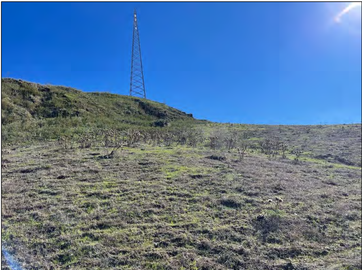
Foto 28 - Panoramica UR 16 (sostegno 034 N linea 135)
