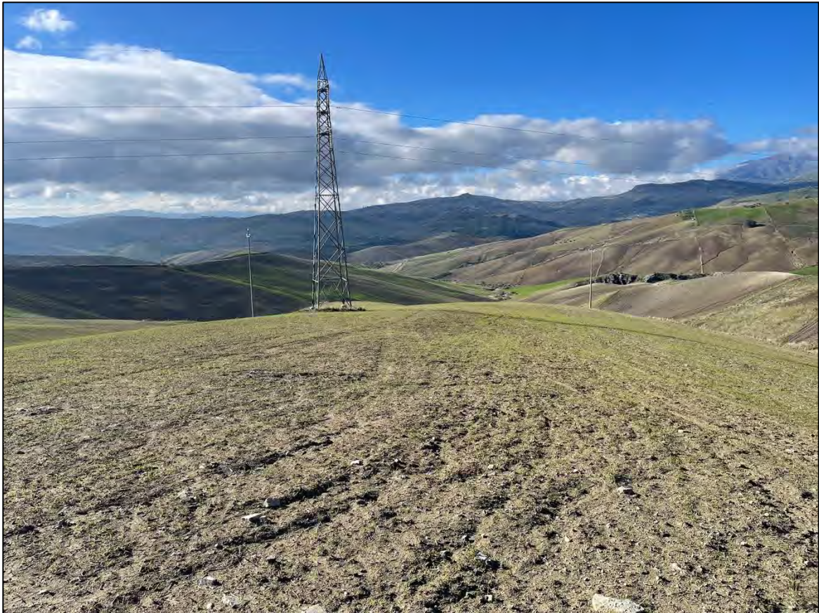
Foto 30 - Panoramica UR 17 (sostegno 063 N linea 135)
