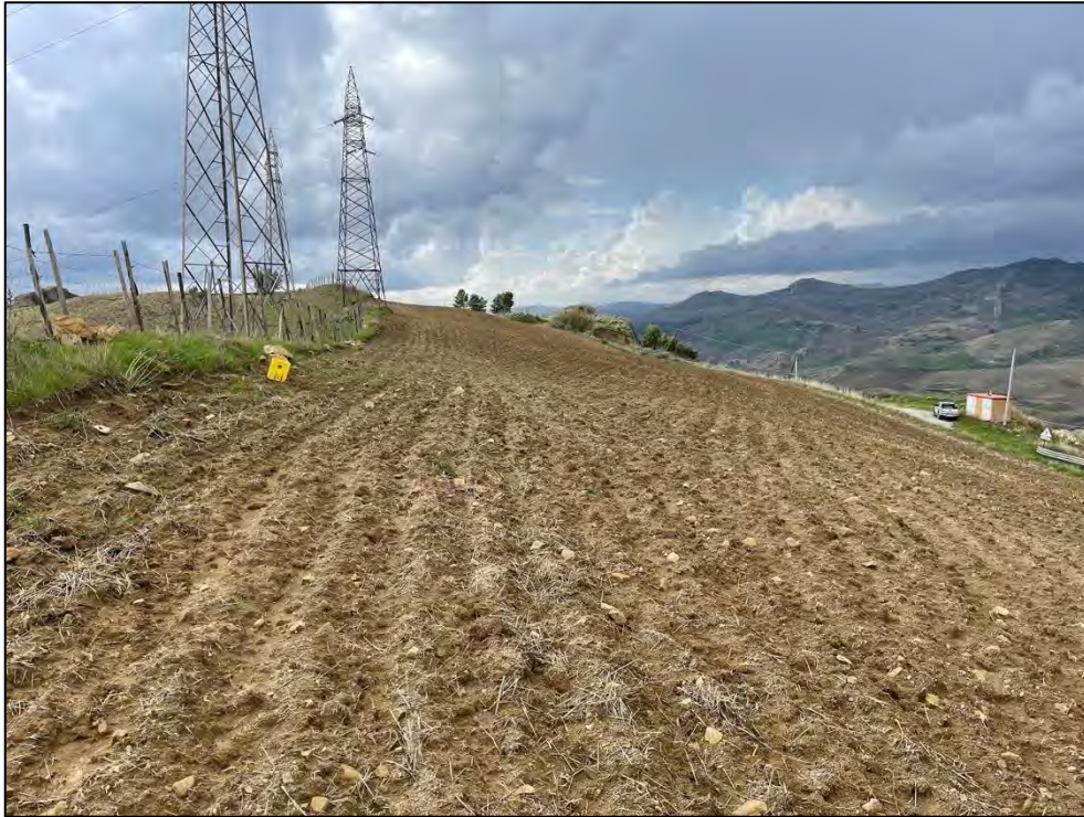
Foto 9 - Panoramica UR 07 (sostegno 011 N linea 135)
