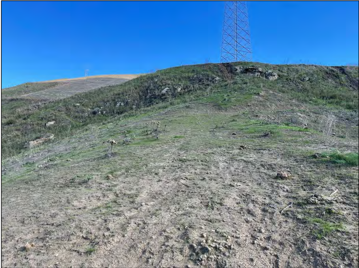
Foto 27 - Panoramica UR 16 (sostegno 034 N linea 135)
