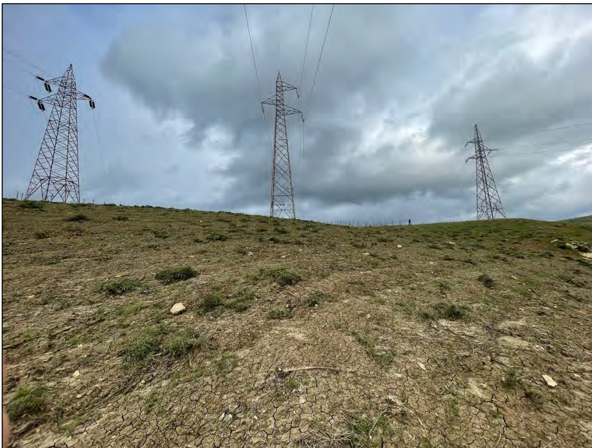
Foto 7 - Panoramica UR 06 (sostegno 011 N linea 135)
