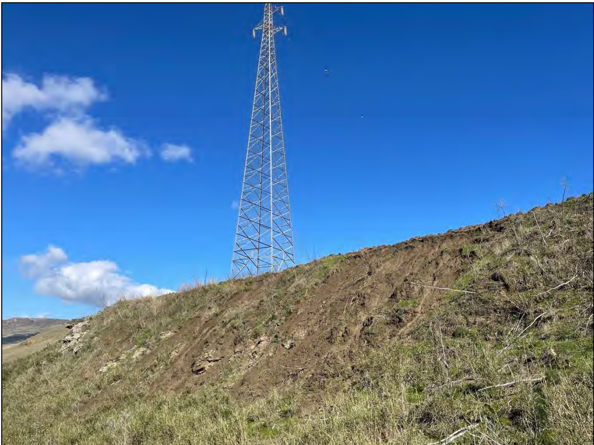
Foto 26 - Panoramica UR 16 (sostegno 034 N linea 135)
