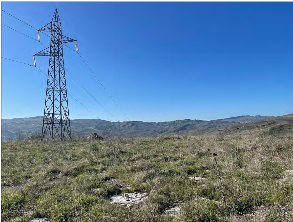
Foto 21 - Panoramica UR 14 (sostegno 026 N linea 135)
