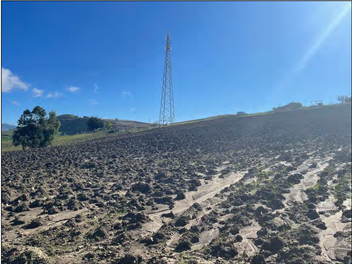
Foto 41 - Panoramica UR 21 (sostegno 005 N linea 84)
