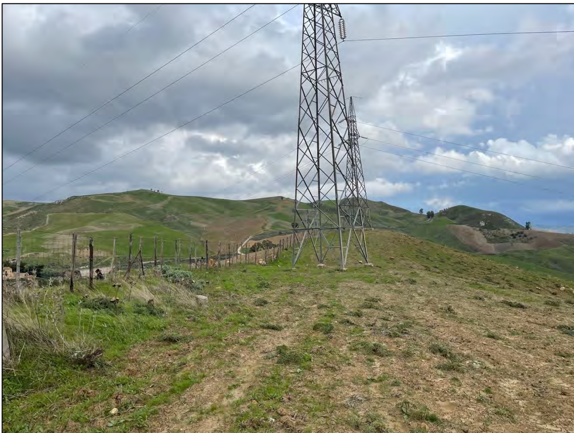
Foto 8 - Panoramica UR 06 (sostegno 011 N linea 135)
