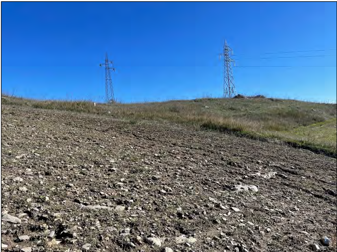
Foto 24 - Panoramica UR 15 (sostegno 034 N linea 135)
