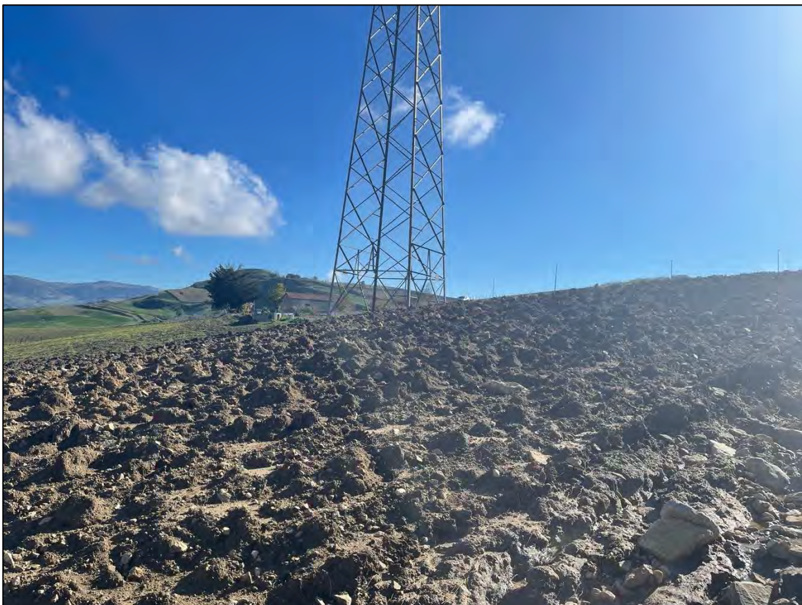
Foto 40 - Panoramica UR 21 (sostegno 005 N linea 84)
