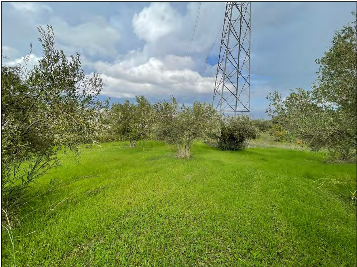
Foto 12 - Panoramica UR 09 (sostegno 017 N linea 135)
