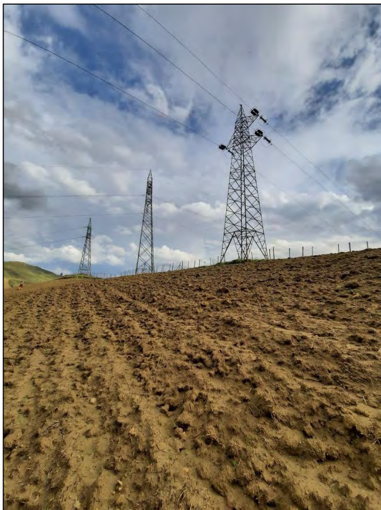
Foto 10 - Panoramica UR 07 (sostegno 011 N linea 135)
