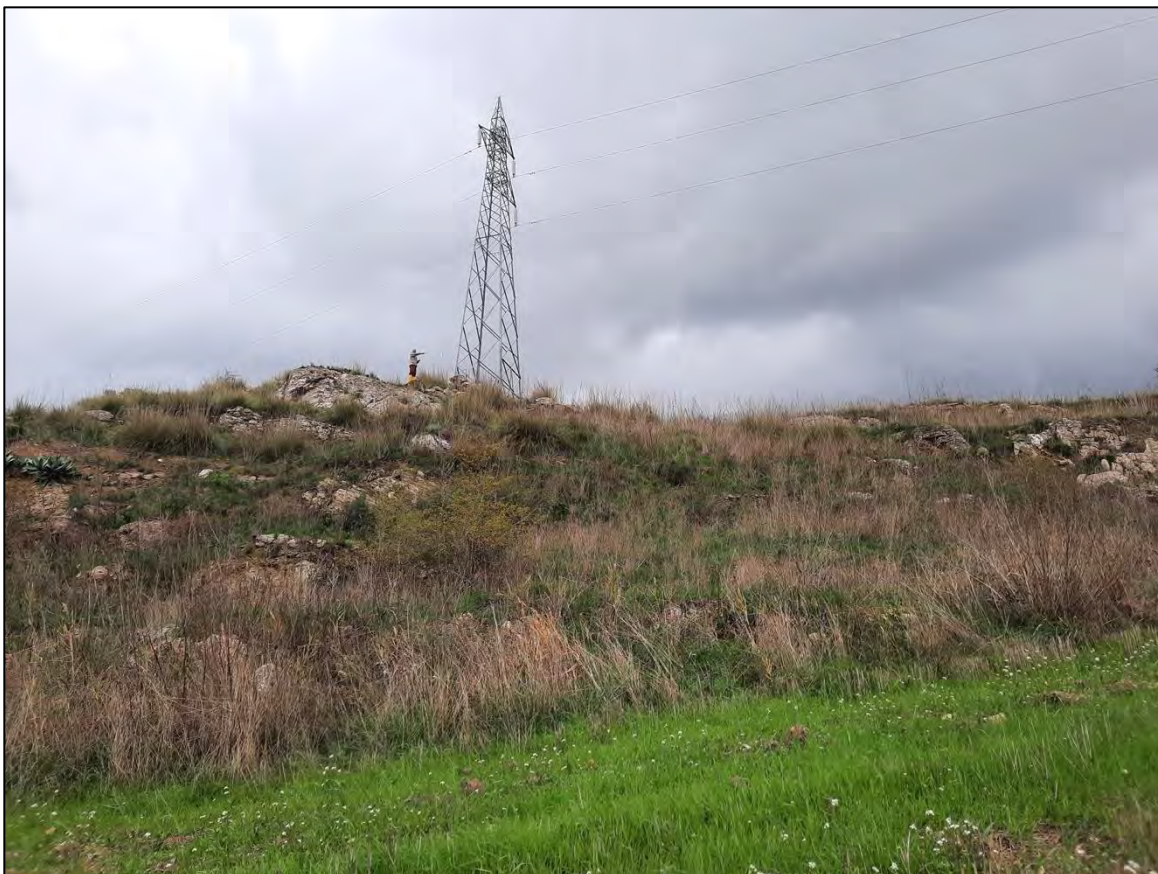
Foto 18 - Panoramica UR 13 (sostegno 018 N linea 135)
