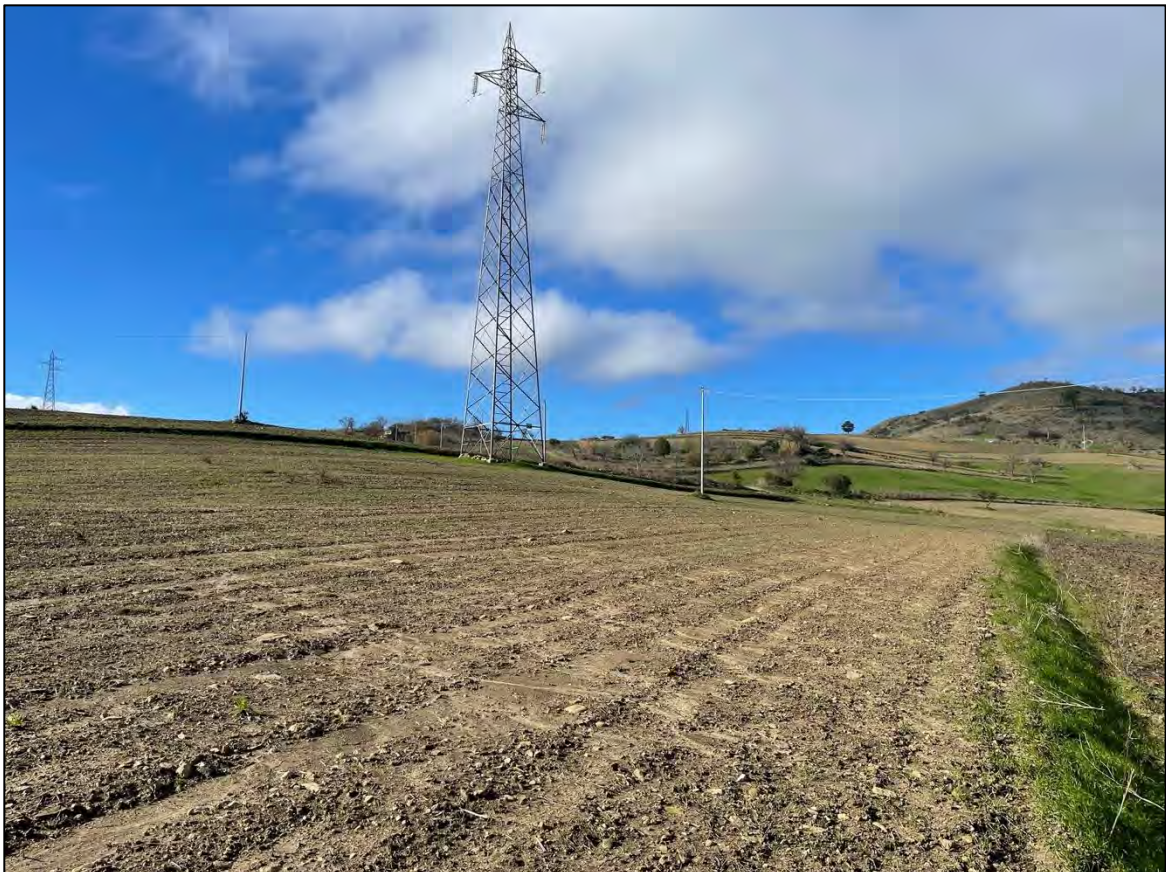
Foto 34 - Panoramica UR 19 (sostegno 004 N linea 84)
