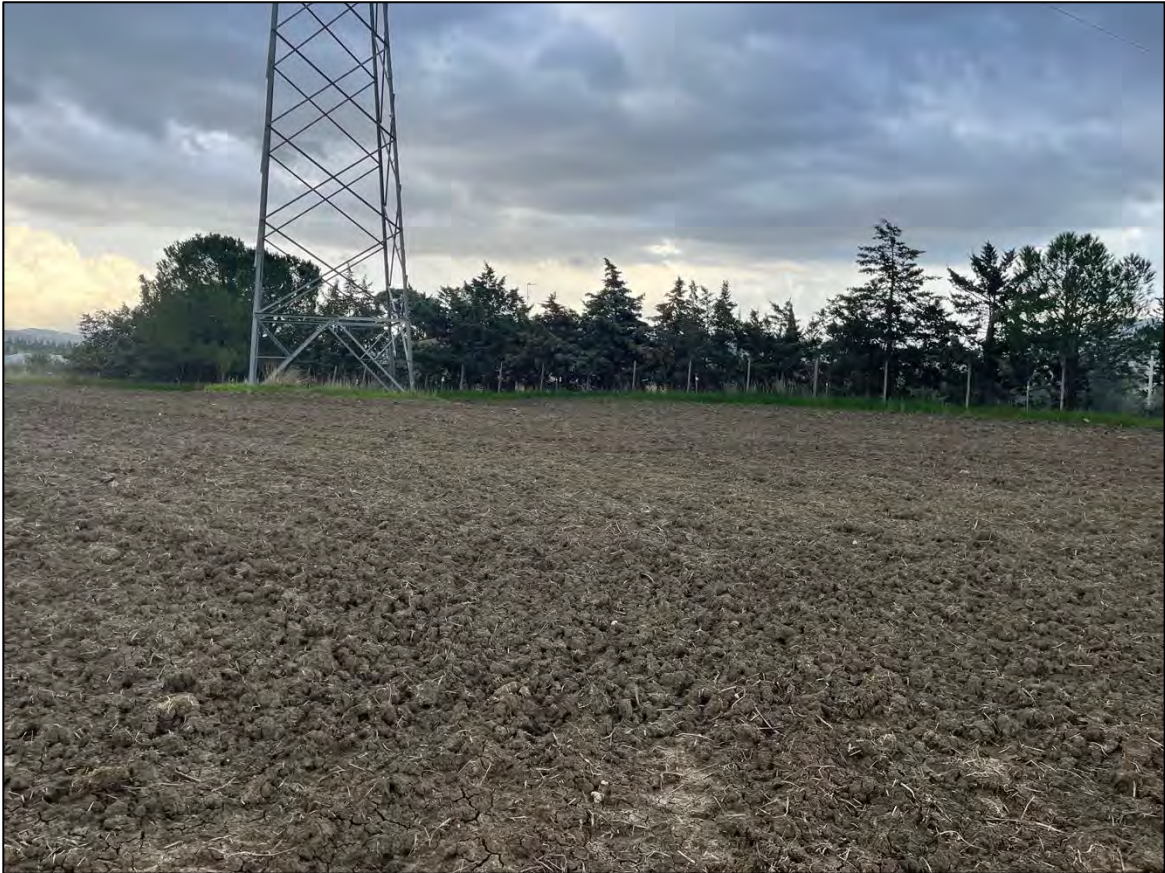
Foto 3 - Panoramica UR 03 (sostegno 004 N linea 135)
