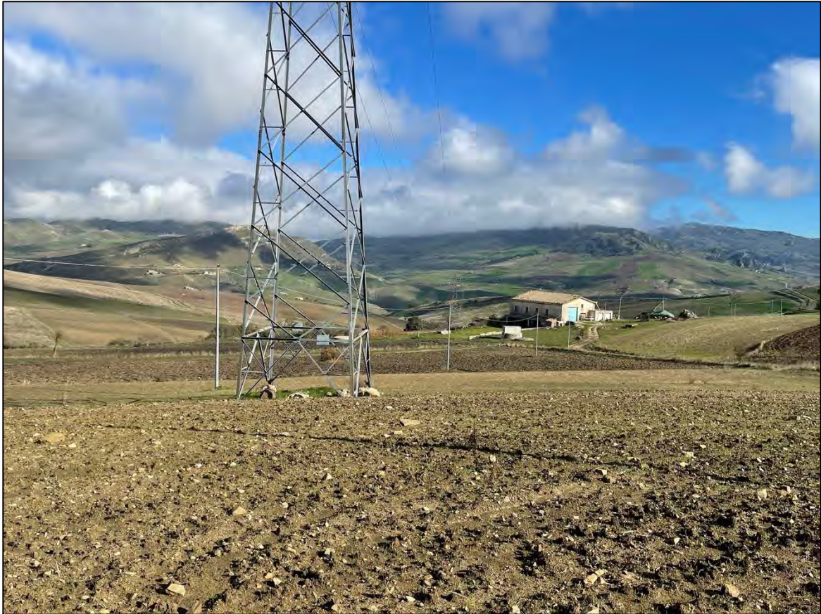
Foto 35 - Panoramica UR 19 (sostegno 004 N linea 84)
