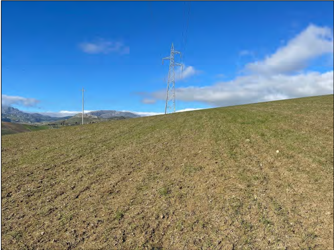
Foto 29 - Panoramica UR 17 (sostegno 063 N linea 135)
