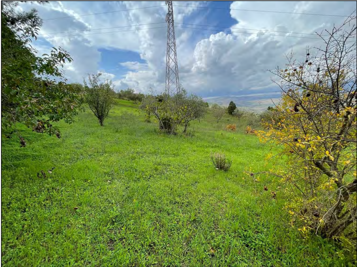
Foto 13 - Panoramica UR 09 (sostegno 017 N linea 135)
