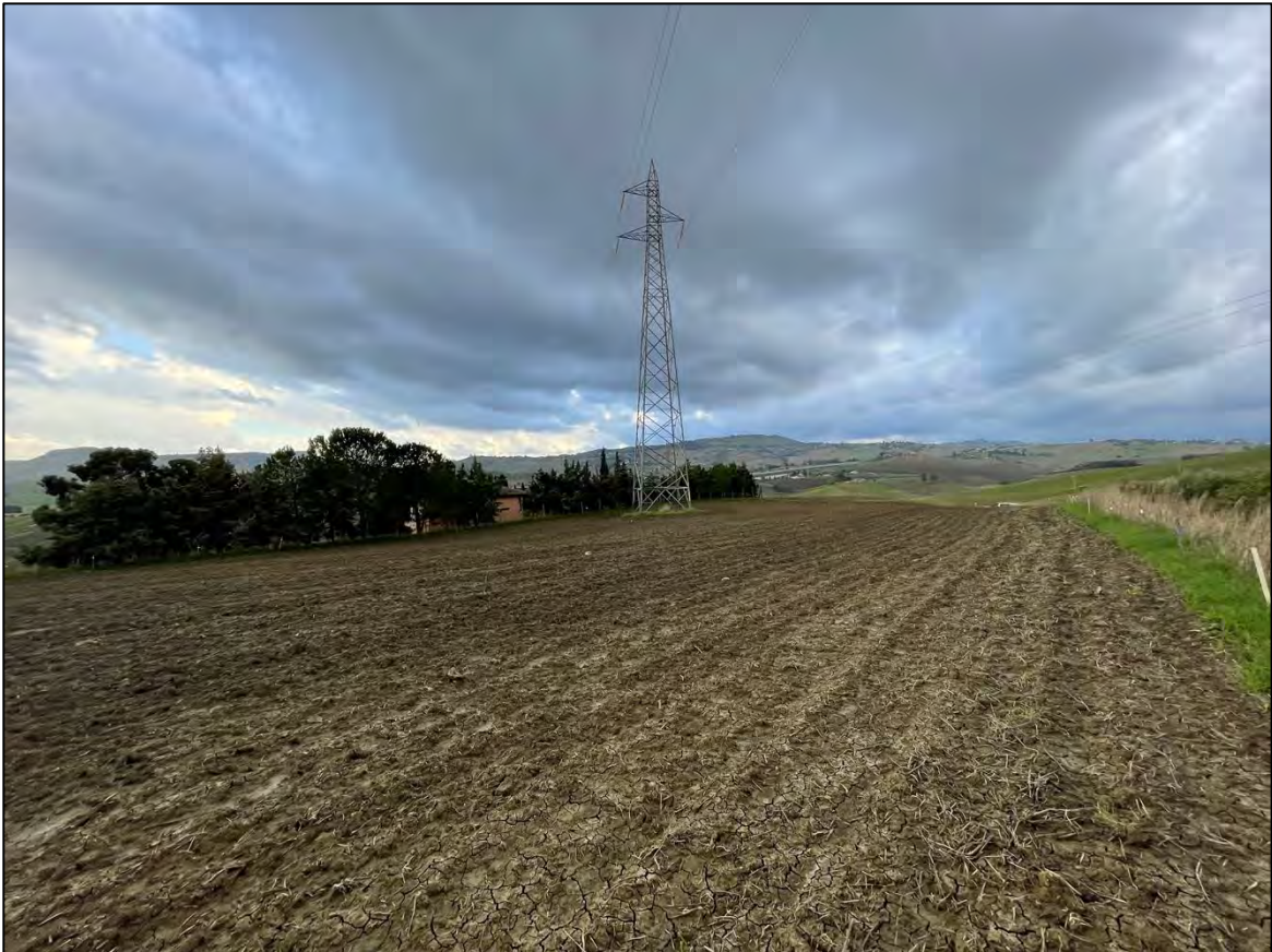
Foto 4 - Panoramica UR 03 (sostegno 004 N linea 135)
