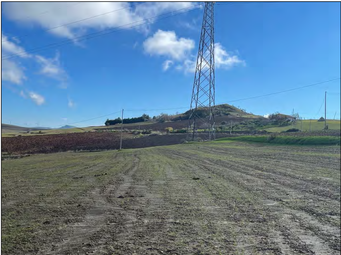
Foto 36 - Panoramica UR 19 (sostegno 004 N linea 84)
