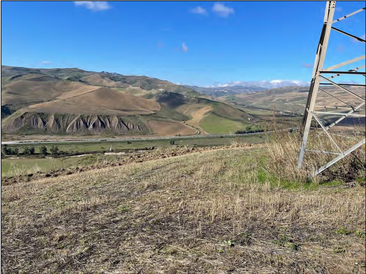
Foto 25 - Panoramica UR 15 (sostegno 034 N linea 135)
