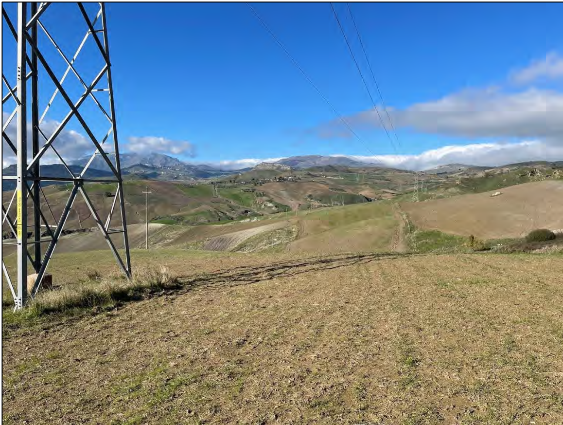
Foto 31 - Panoramica UR 17 (sostegno 063 N linea 135)
