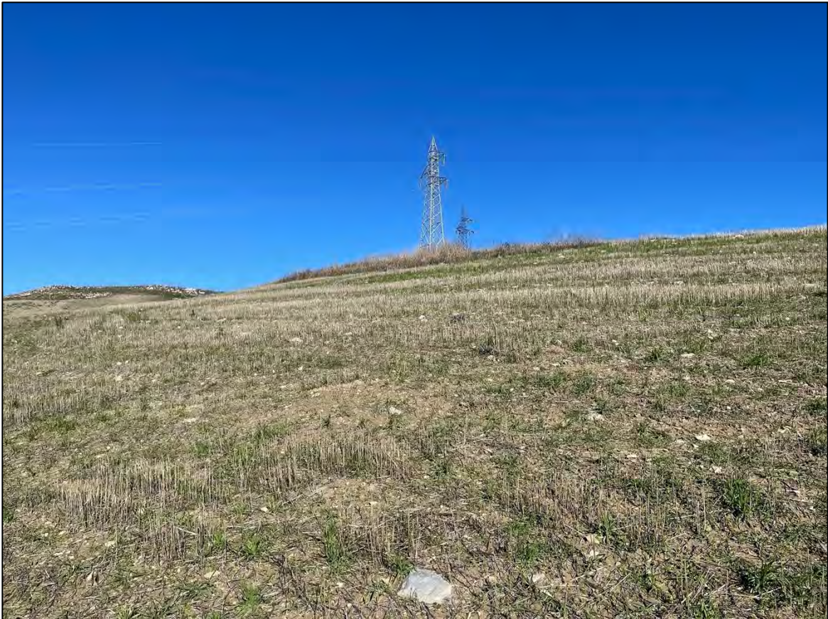
Foto 20 - Panoramica UR 14 (sostegno 026 N linea 135)
