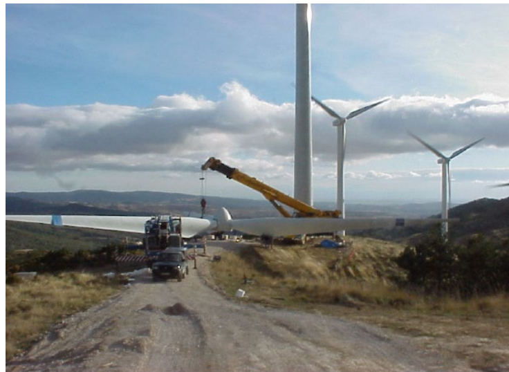
Figura 3-2: Ingombro del rotore a terra
