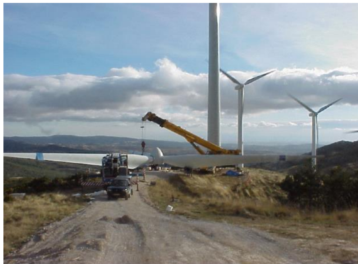
Figura 2-4: Ingombro del rotore a terra
